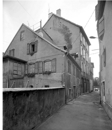
Façade sur la rue des Tanneries.
