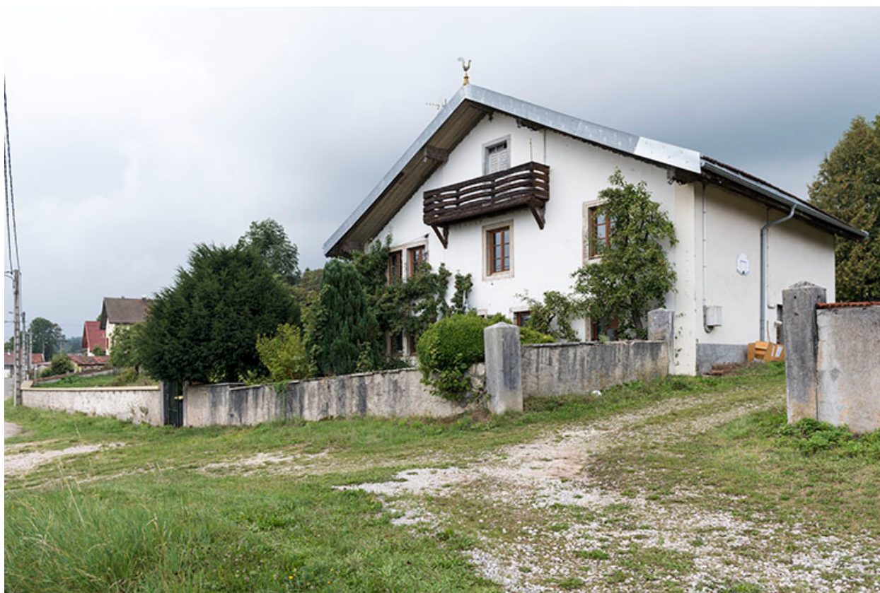
Façades antérieure et latérale droite.
