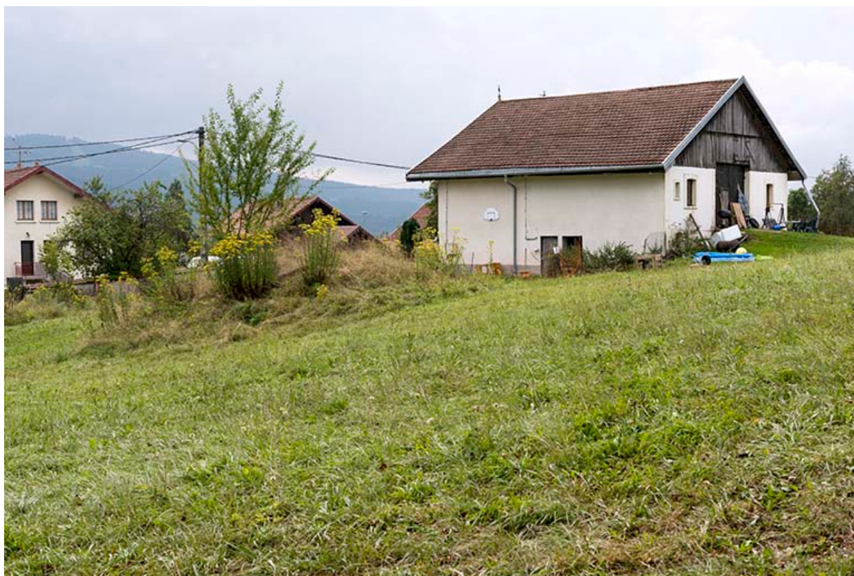
Façades postérieure et latérale droite.
