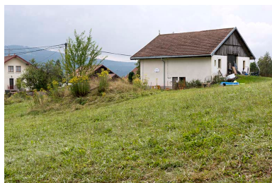
Façades postérieure et latérale droite.
