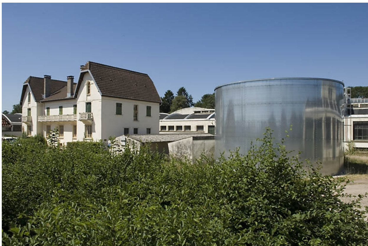
Le bâtiment des bureaux depuis le sud-est.
