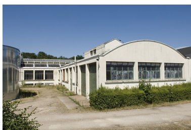
Détail d'un atelier de fabrication. Phot. Jérôme Mongreville IVR43_20067000638NUCA
