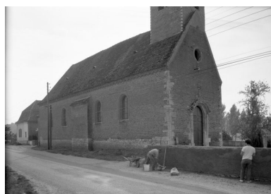
Elévations antérieure et gauche Phot. Jean-Luc Duthu IVR26_19852100902V
