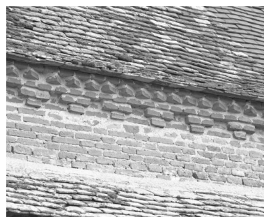
Détail de la corniche Phot. Jean-Luc Duthu IVR26_19852100903V
