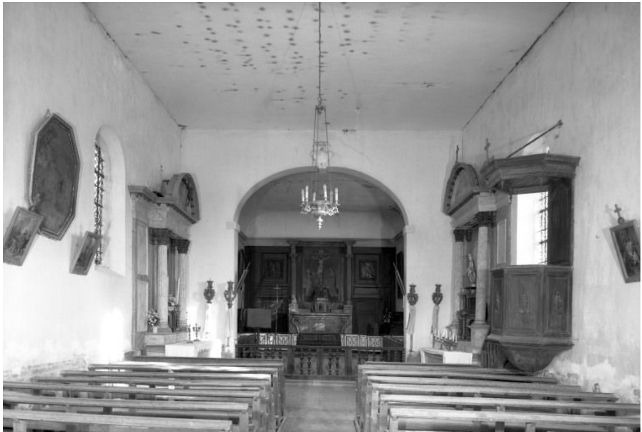
Vue intérieure prise de l'entrée
