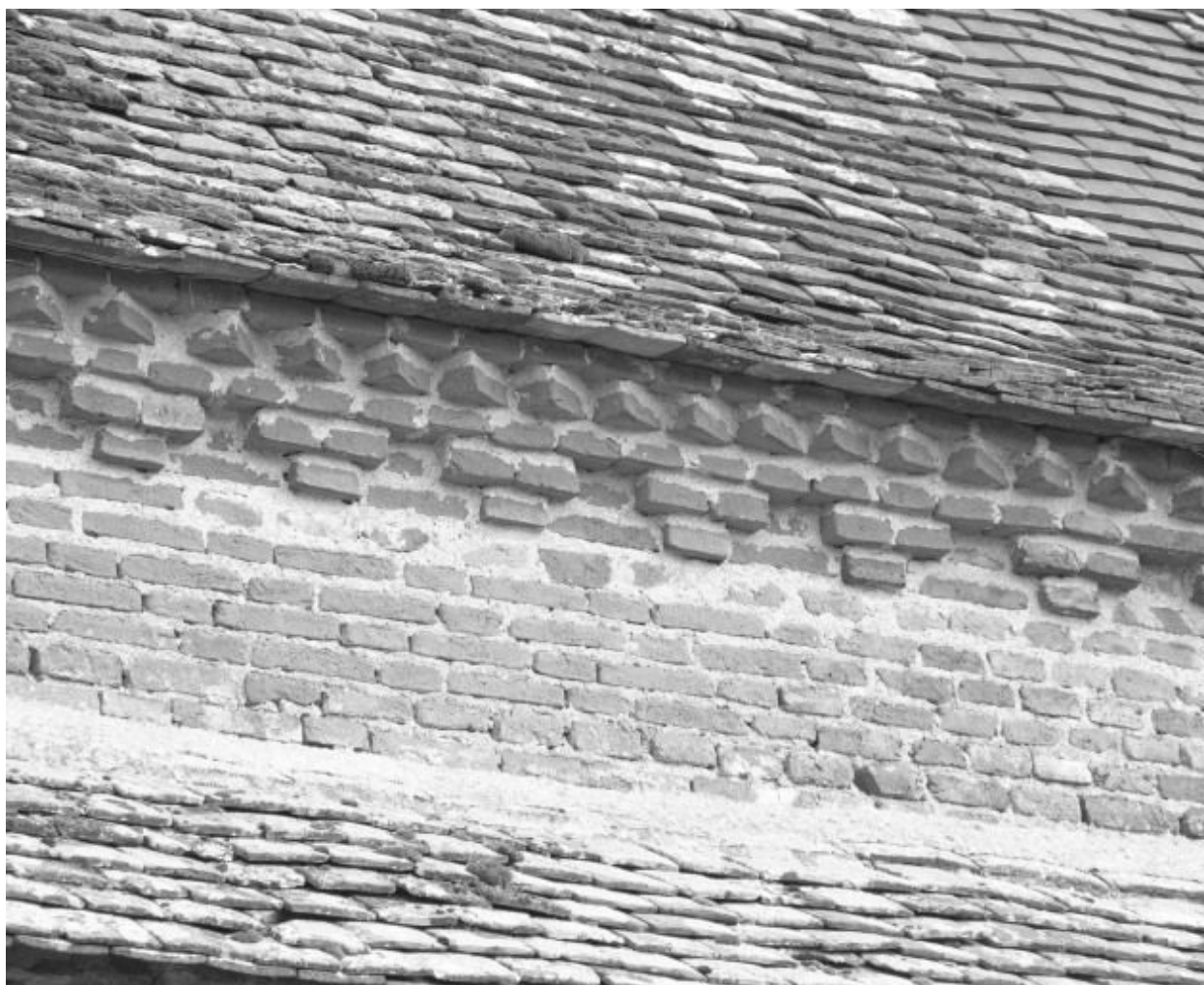
Détail de la corniche
