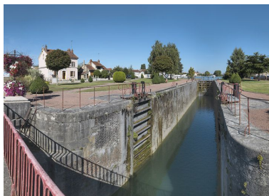
Site d'écluse vu d'amont : portes et bajoyers. Phot. Thierry Kuntz IVR26_20128900624NUC4A
