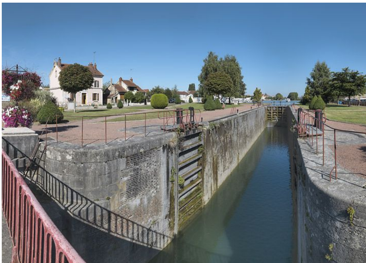
Site d'écluse vu d'amont : portes et bajoyers.
