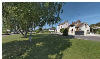
Site d'écluse vu d'aval. Phot. Thierry Kuntz IVR26_20128900622NUC4A
