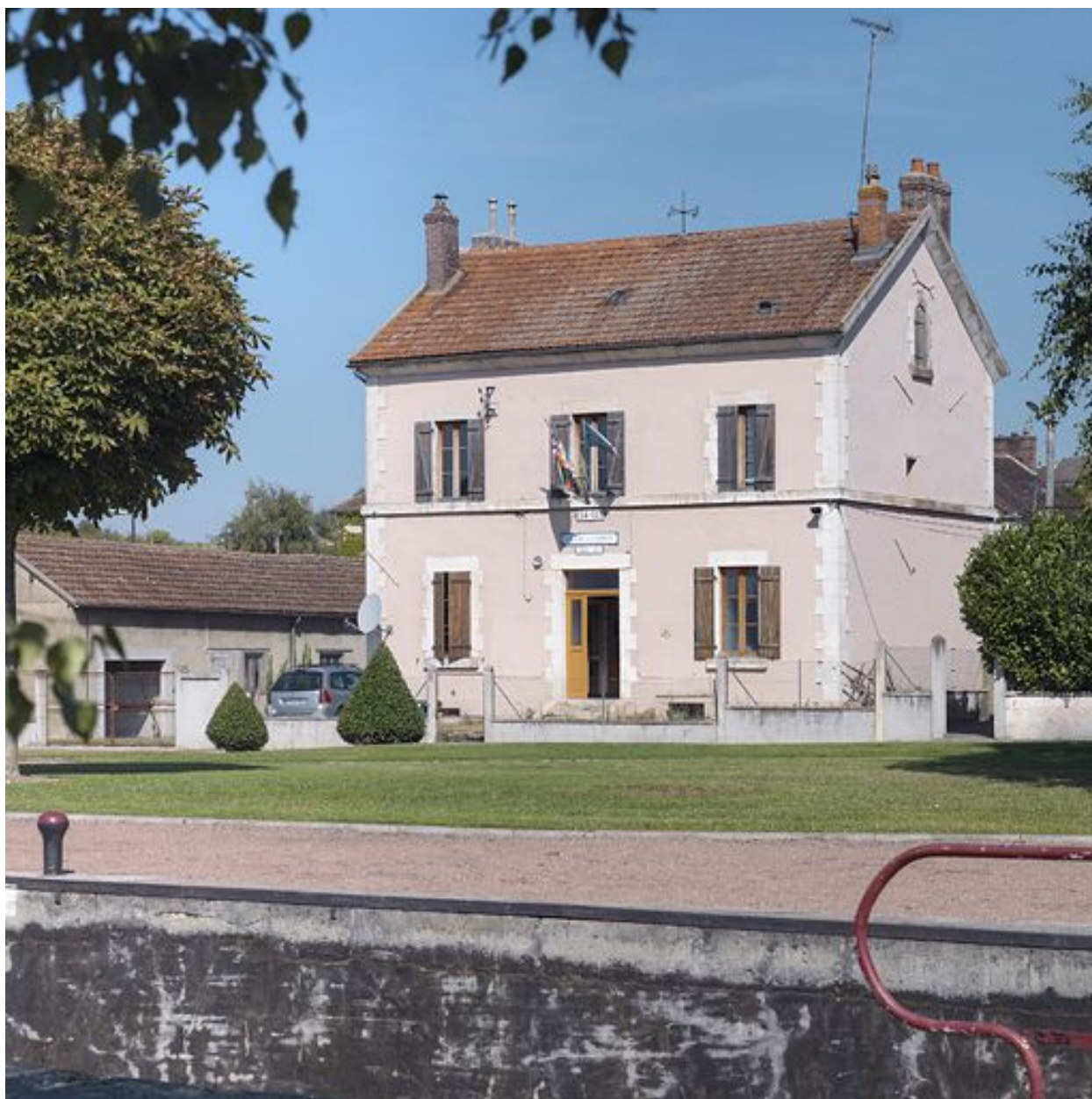
La maison éclusière et de perception de 3/4.
