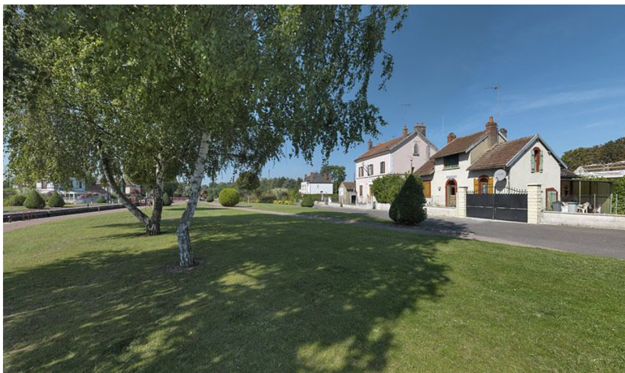
Site d'écluse vu d'aval.
