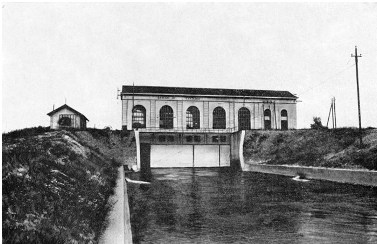
USINE DU CHATELOT : Vue aval.
