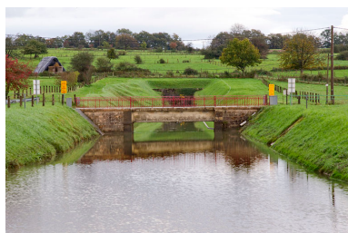
Pont routier sur le bief d'amenée. Phot. Yves Sancey IVR43_20122502053NUC2A
