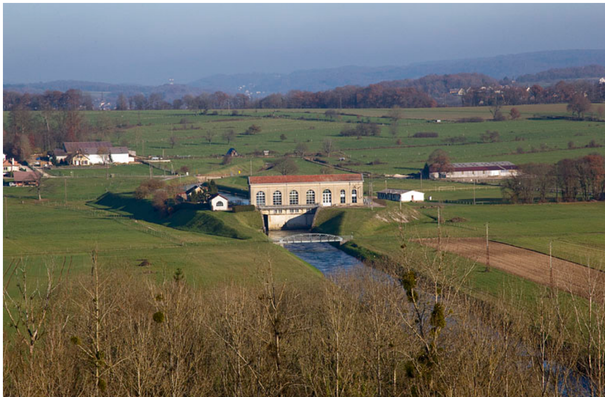
Vue d'ensemble plongeante depuis l'ouest.
