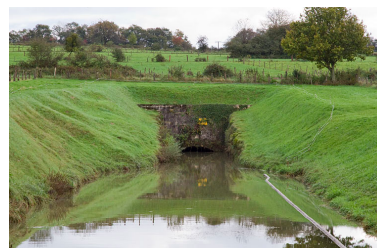
Bief d'amenée. Tête du tunnel. Phot. Yves Sancey IVR43_20122502055NUC2A
