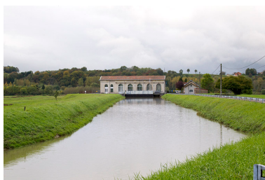
La centrale depuis le bief d'amenée. Phot. Yves Sancey IVR43_20122502056NUC2A
