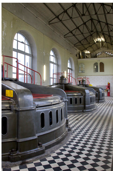
Alignement des groupes turbo-alternateurs dans la salle des machines. Phot. Yves Sancey IVR43_20122502059NUC2A
