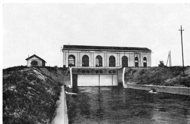
USINE DU CHATELOT : Vue aval.
