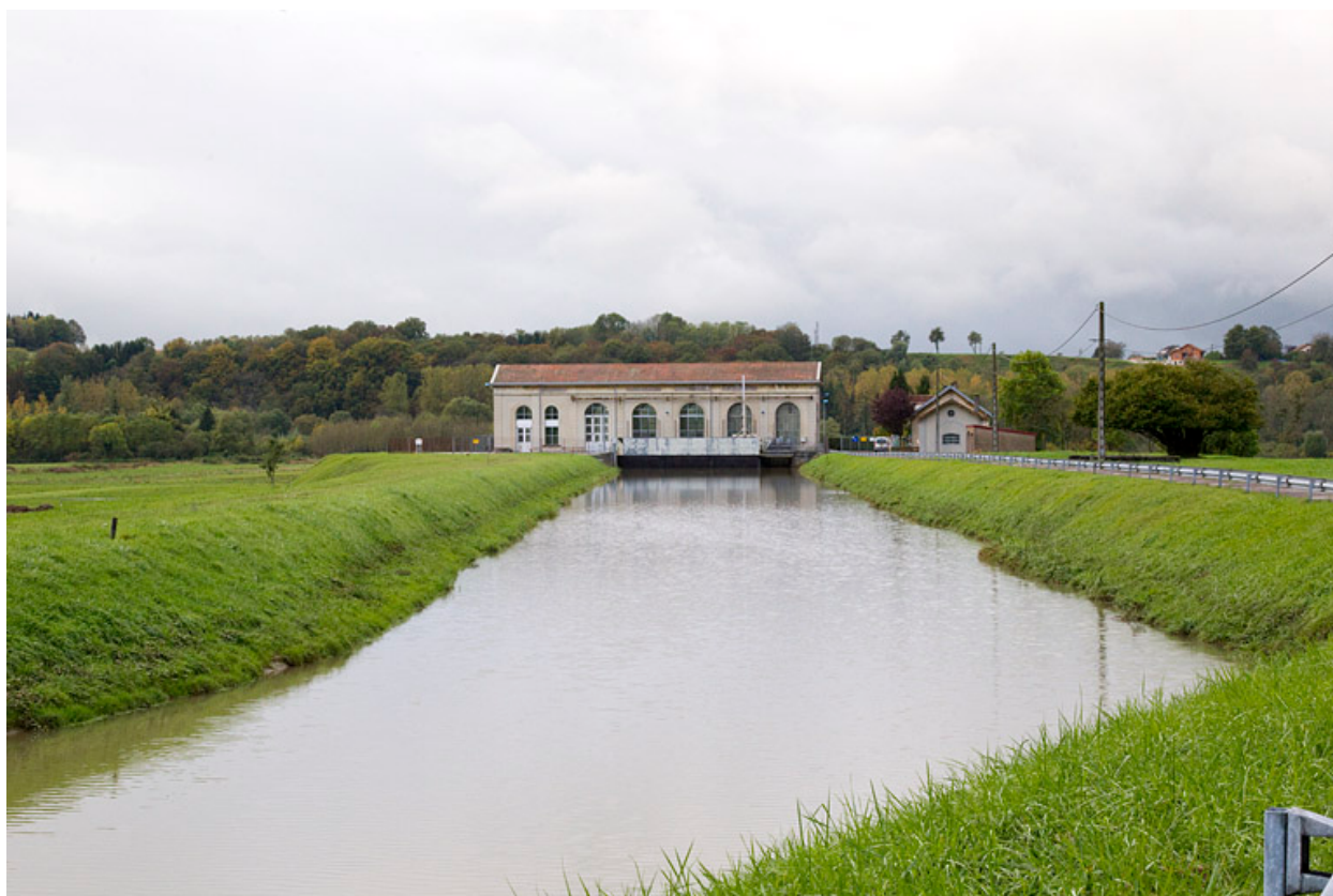
La centrale depuis le bief d'amenée.
