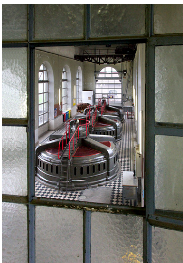
Vue plongeante sur la salle des machines. Phot. Yves Sancey IVR43_20122502069NUC2A
