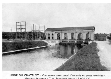
Centrale du Châtelot. Canal d'amenée, s.d. [vers 1935]. Autr. auteur inconnu IVR43_20132500931NUC4A
