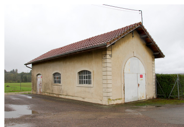
Atelier d'entretien. Phot. Yves Sancey IVR43_20122502070NUC2A
