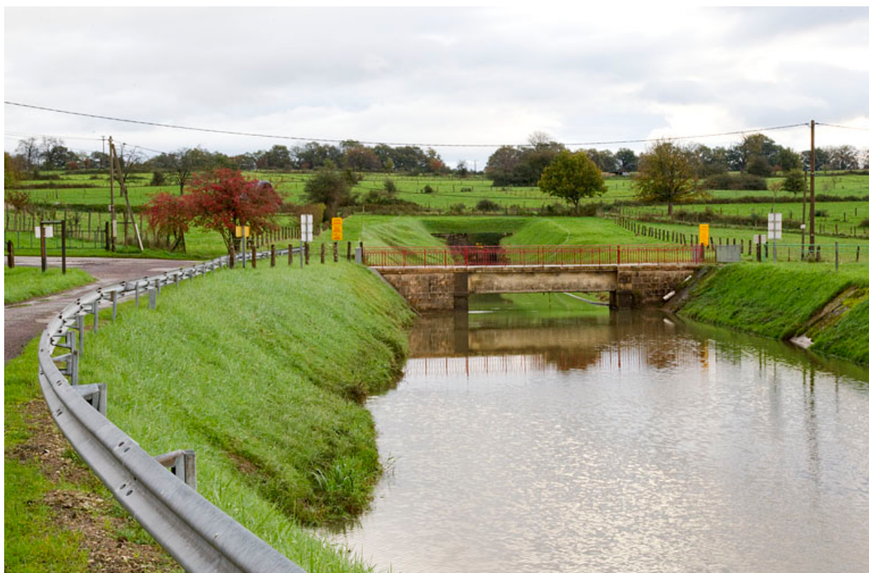
Bief d'amenée à la sortie du tunnel.
