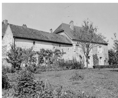
Façades postérieures de l'habitation et des communs. Phot. Yves Sancey IVR43_19777000225X
