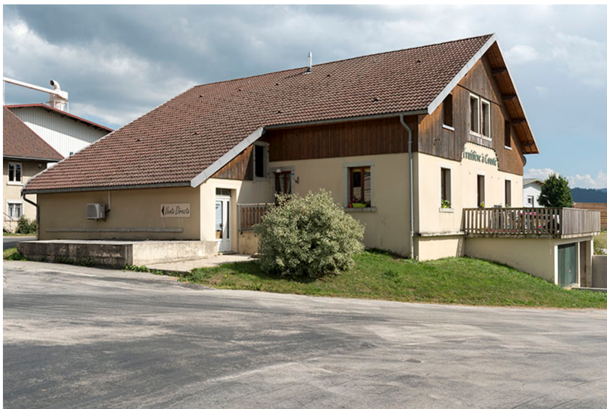
Façades postérieure et latérale droite.
