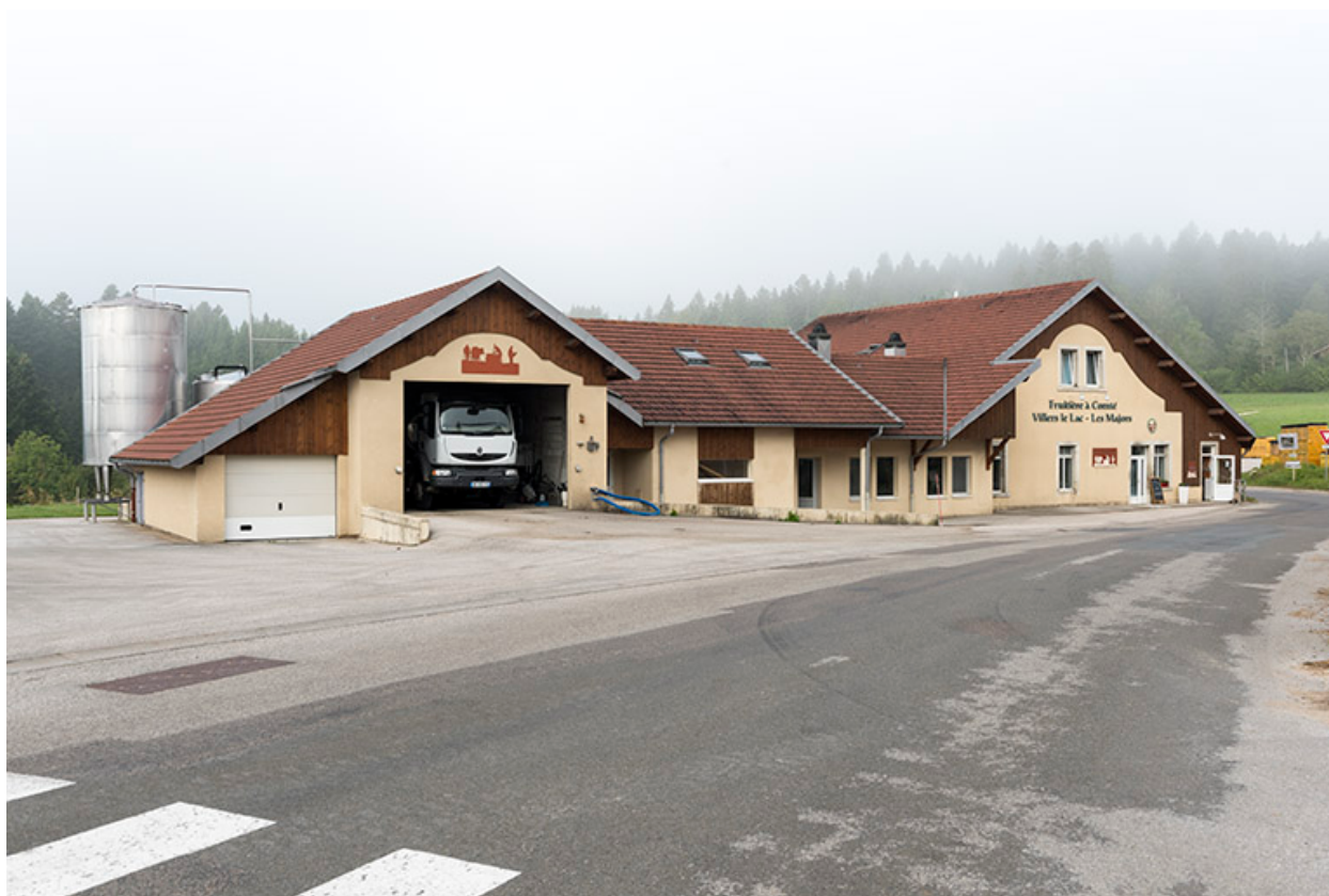
Vue d'ensemble, depuis l'est (façade antérieure).
