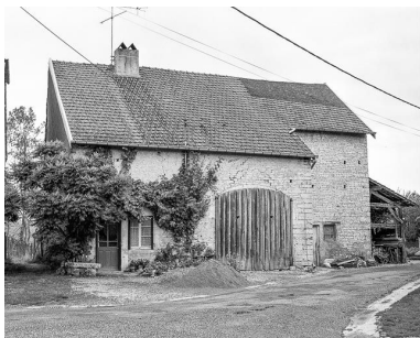
Ferme située 2 rue de la Riotte. Phot. Dominique Dominguez IVR43_19807000431X
