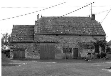
Ferme située rue de la Riotte. Phot. Dominique Dominguez IVR43_19807000430X
