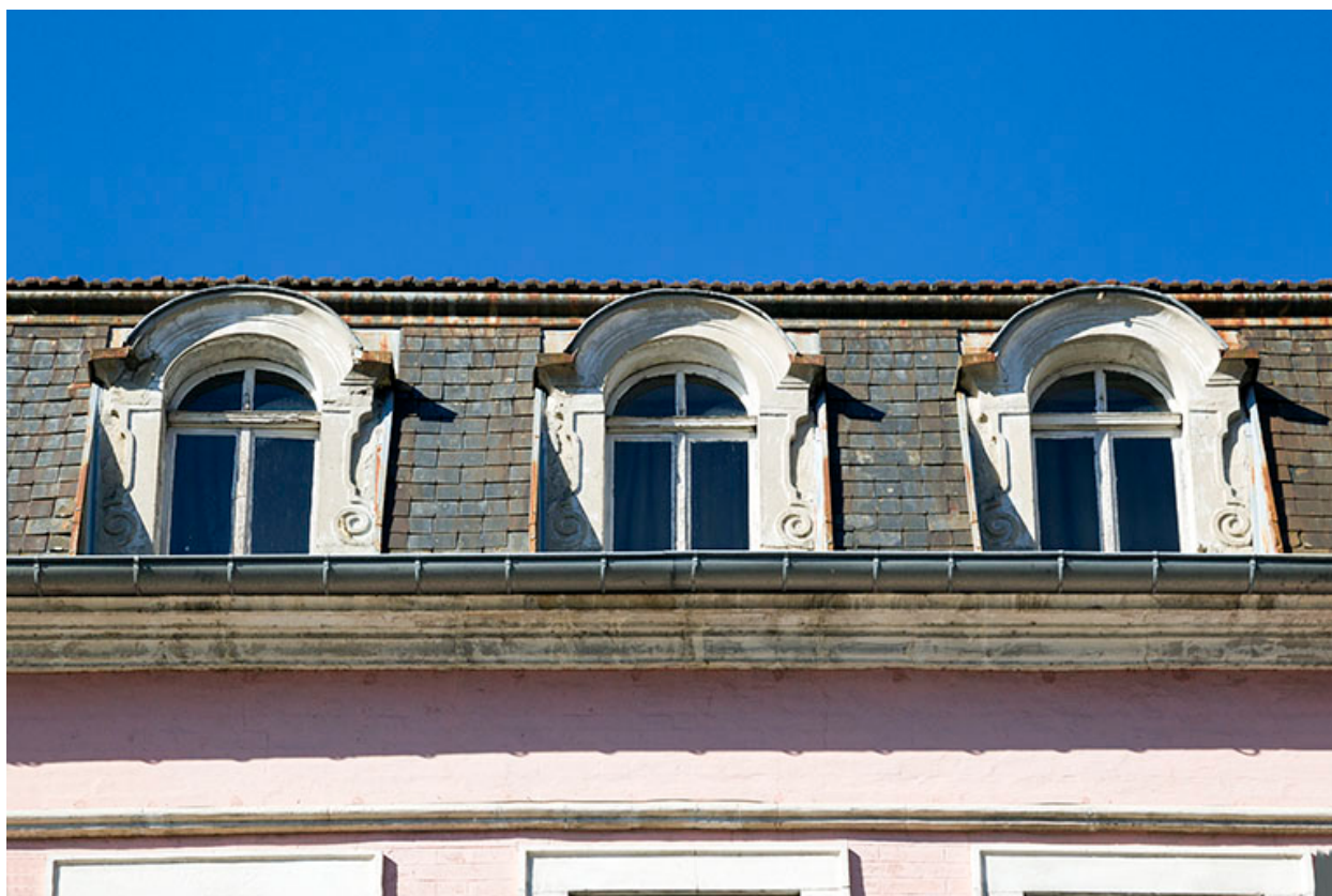
Façade antérieure : lucarnes.
