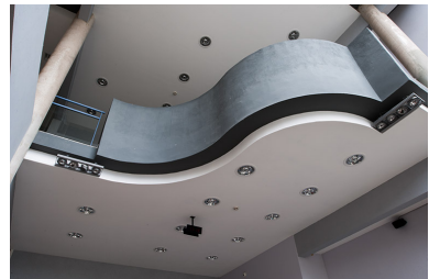
Vue intérieure de l'escalier de l'externat. Phot. Jérôme Mongreville IVR43_20137000609NUC4A
