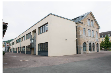
Pignons sud des deux parties de l'externat. Phot. Mary Ruffinoni IVR43_20137000567NUC4A
