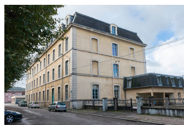
Façade est donnant sur la place du 11 ème chasseur, pignon nord de l'administration-internat. Phot. Mary Ruffinoni IVR43_20157000001NUC4A
