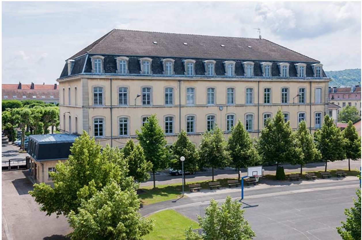
Façade ouest sur cour de l'administration-internat.
