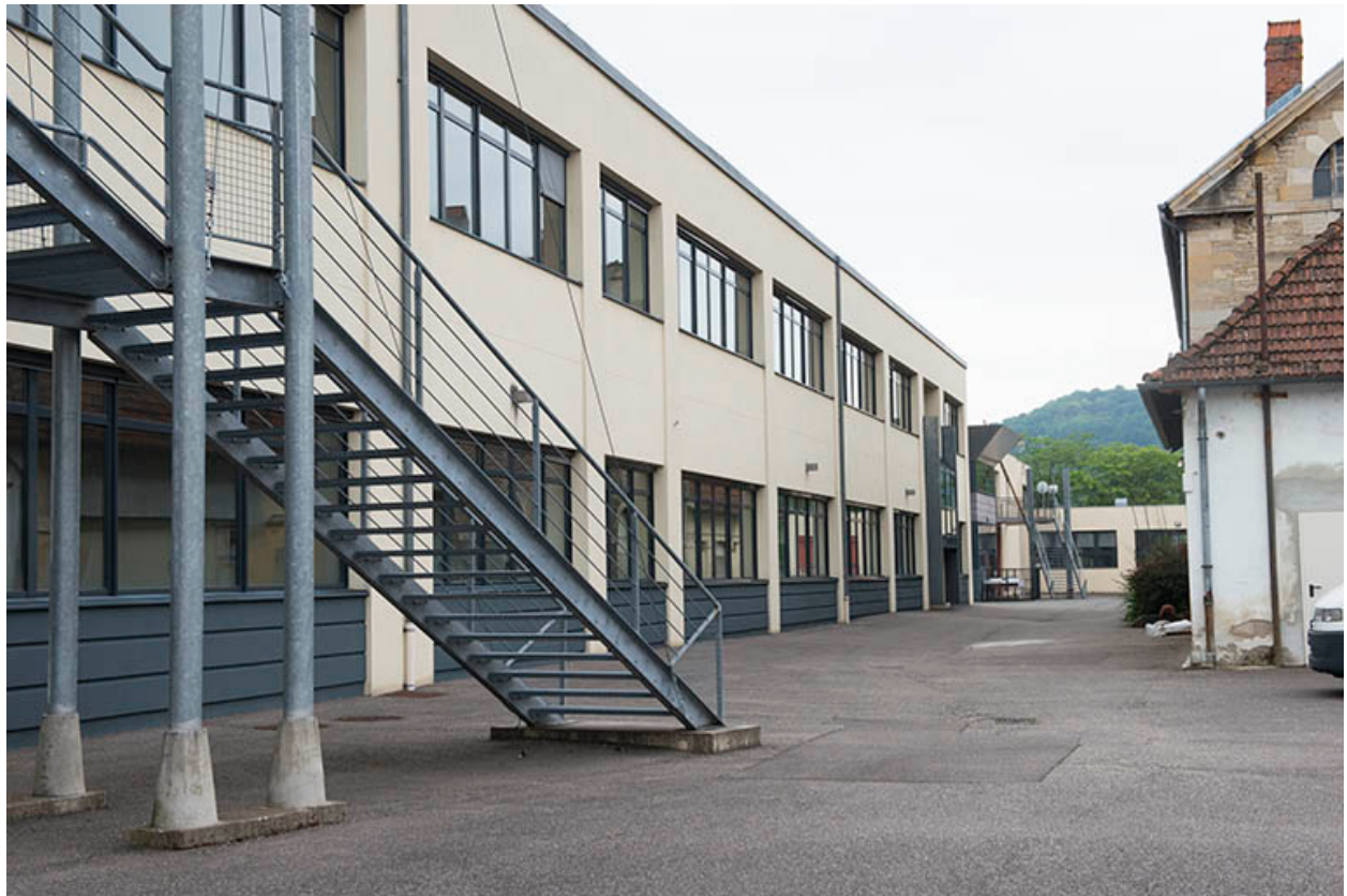
Façade ouest de l'externat.
