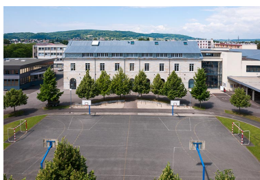
Cour, stade et façade est de l'externat. Phot. Jérôme Mongreville IVR43_20137000616NUC4A
