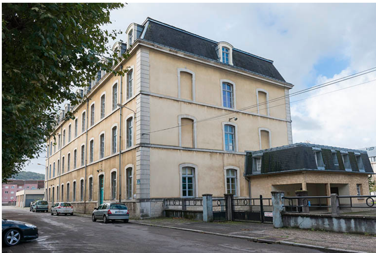
Façade est donnant sur la place du 11 ème chasseur, pignon nord de l'administration-internat.
