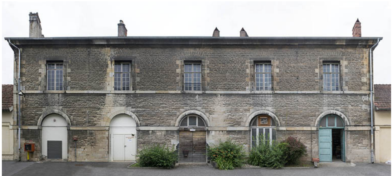
Façade antérieure de l'atelier des agents.
