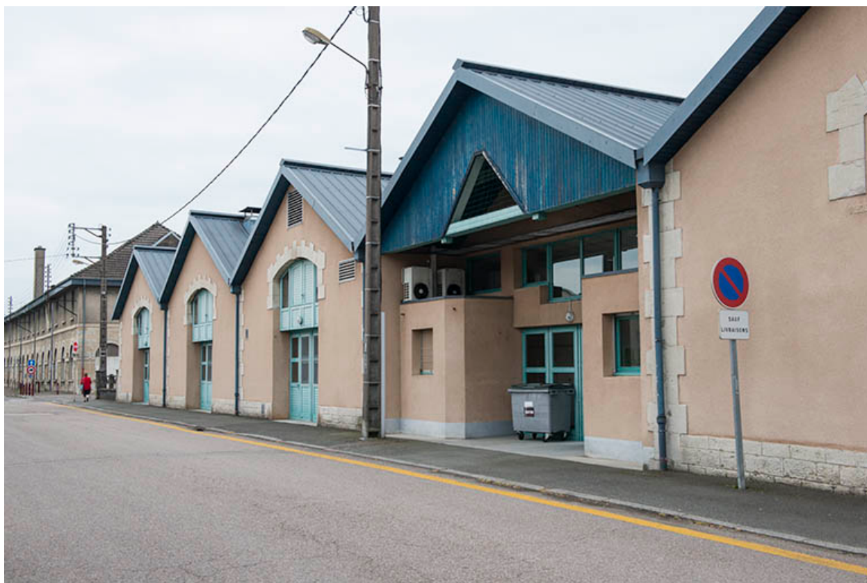
Façade nord de la cantine.
