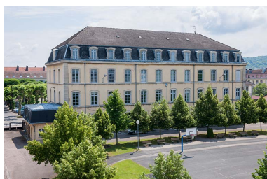
Façade ouest sur cour de l'administration-internat. Phot. Jérôme Mongreville IVR43_20137000619NUC4A
