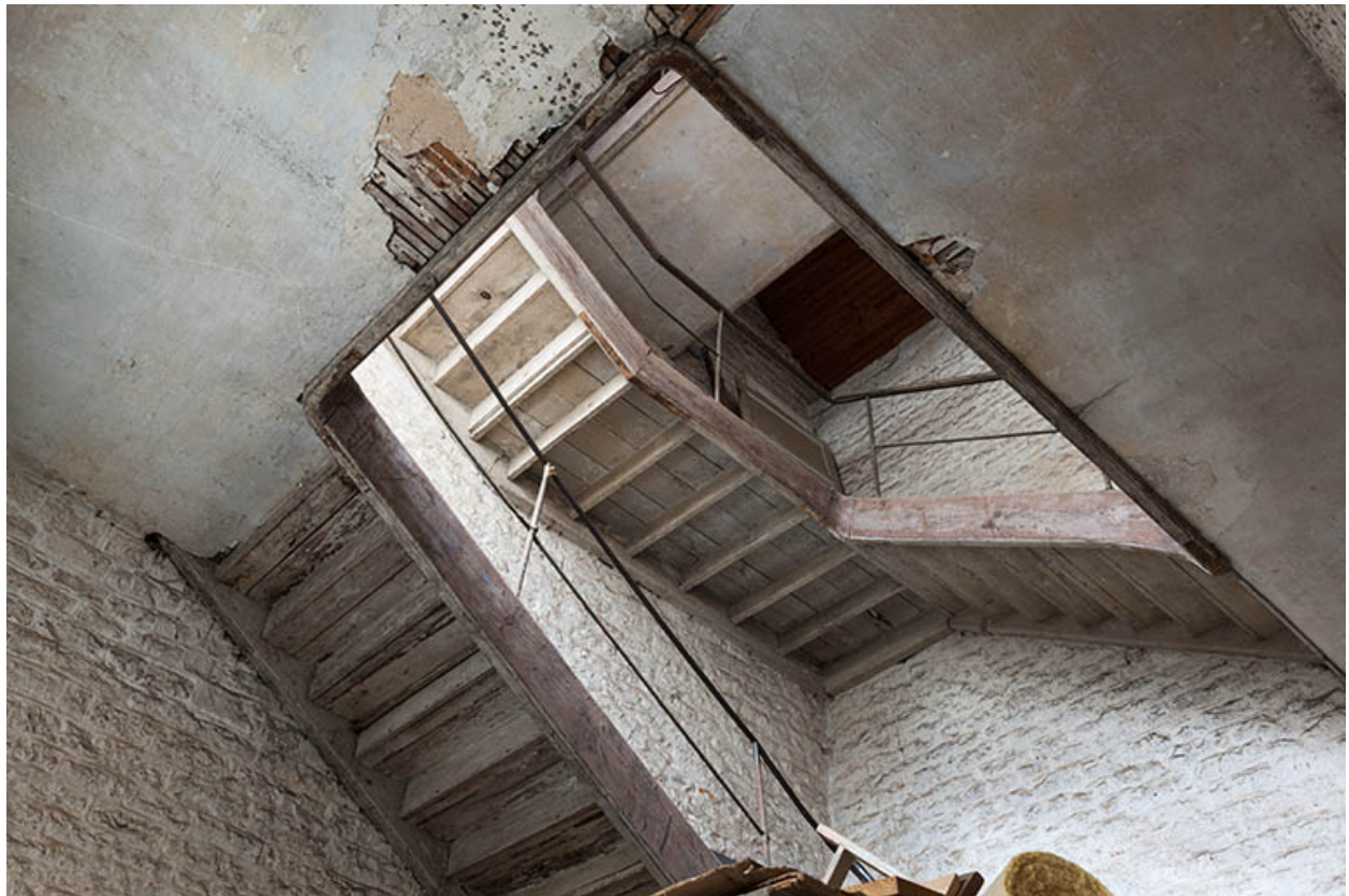
Escalier dans l'atelier des agents.
