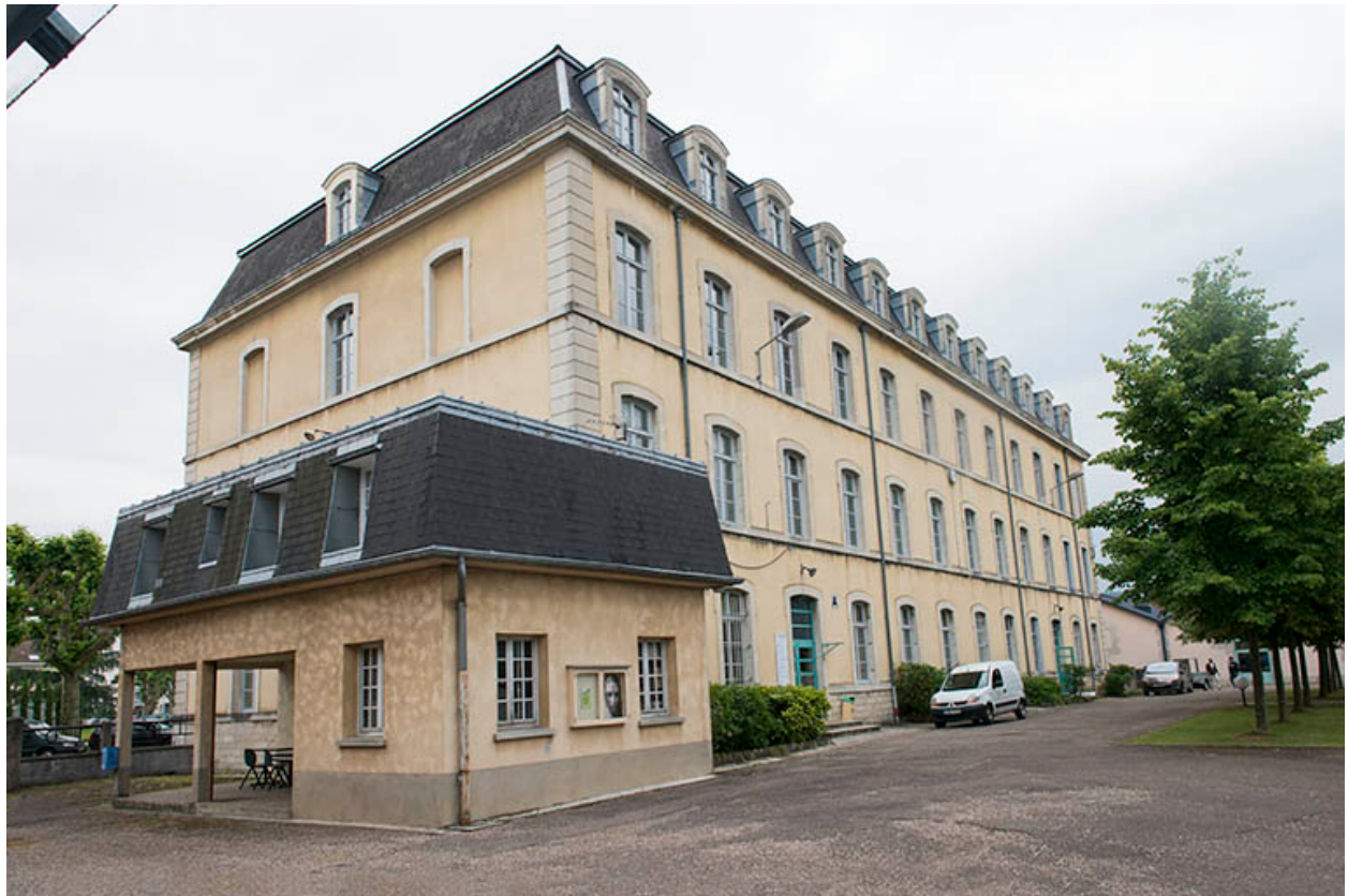
Pignon nord-ouest de l'administration-internat.
