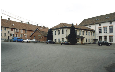
Logement ouvrier et bureau depuis la cour. Phot. Yves Sancey IVR43_20009000688ZA
