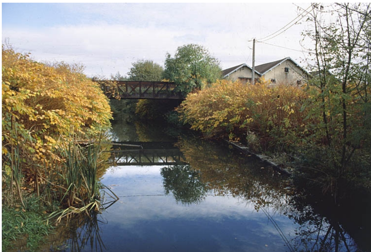
Canal d'amenée depuis l'aval.
