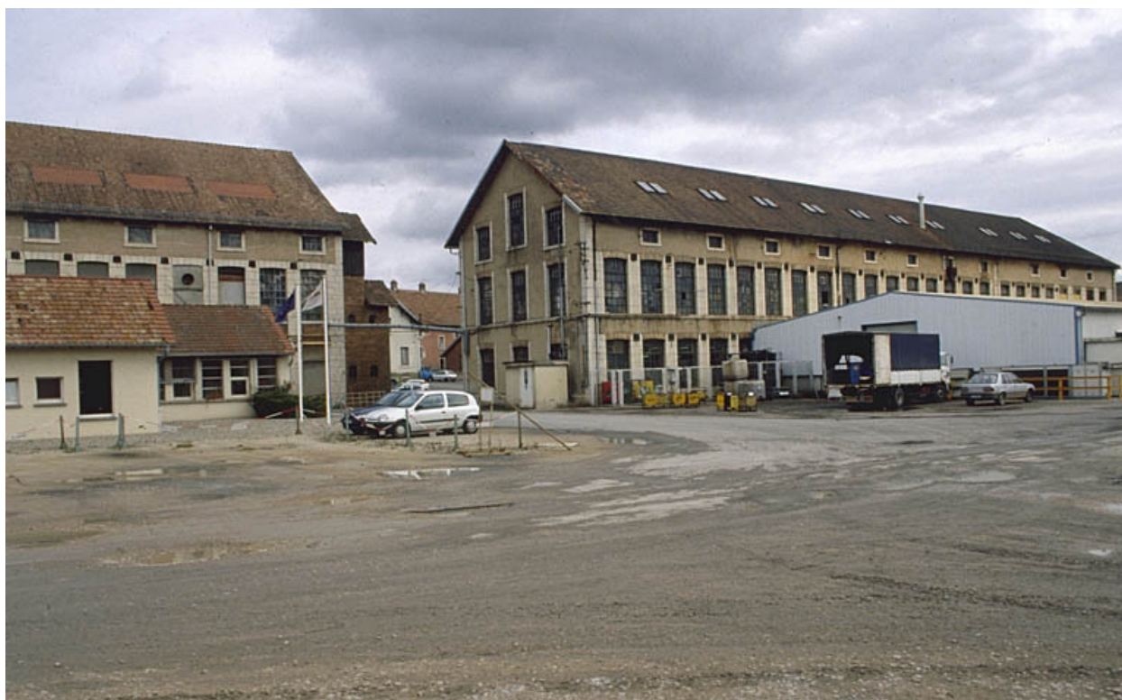
Ateliers de fabrication depuis l'ouest.
