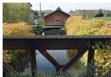
Passerelle sur le canal d'aménée. Phot. Yves Sancey IVR43_20009000722ZA
