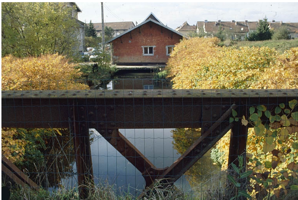
Passerelle sur le canal d'amenée.
