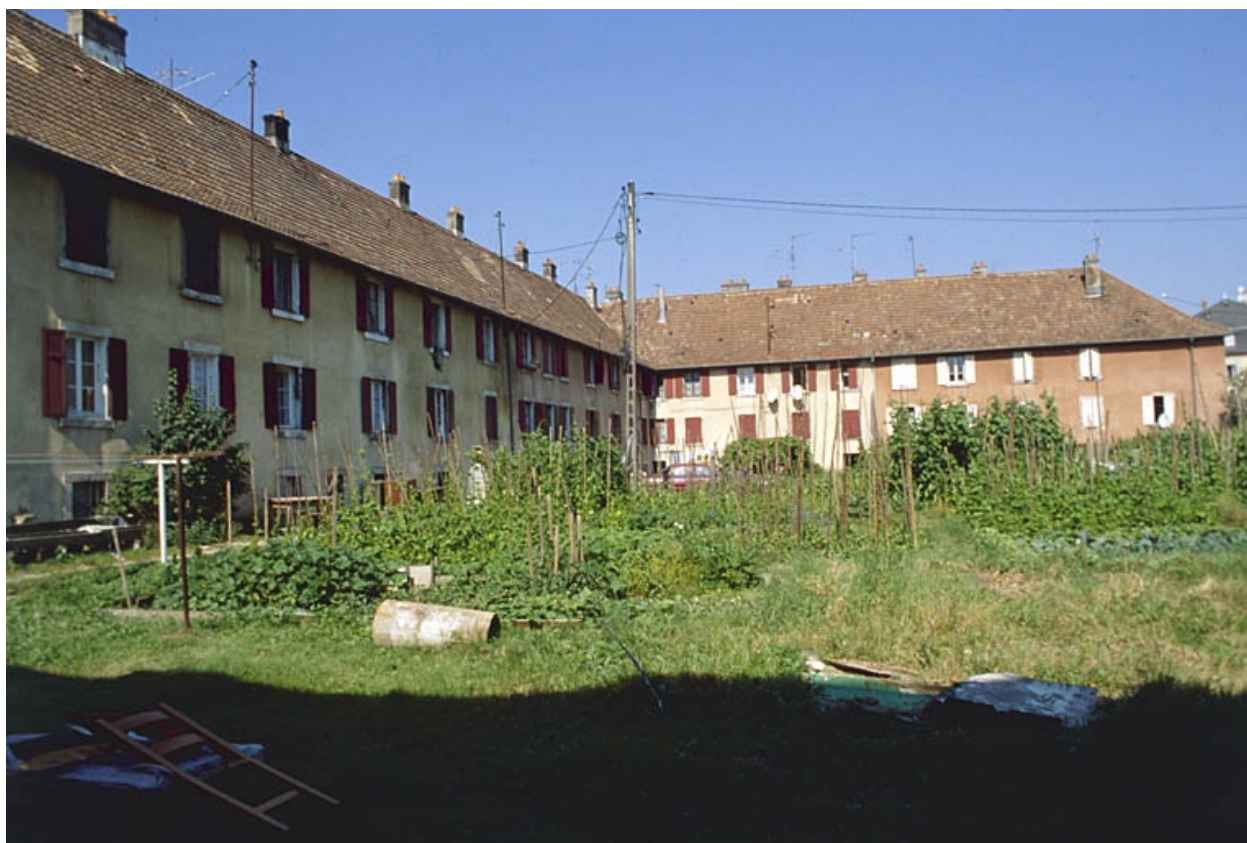
Jardins et logement ouvrier dit la Caserne.
