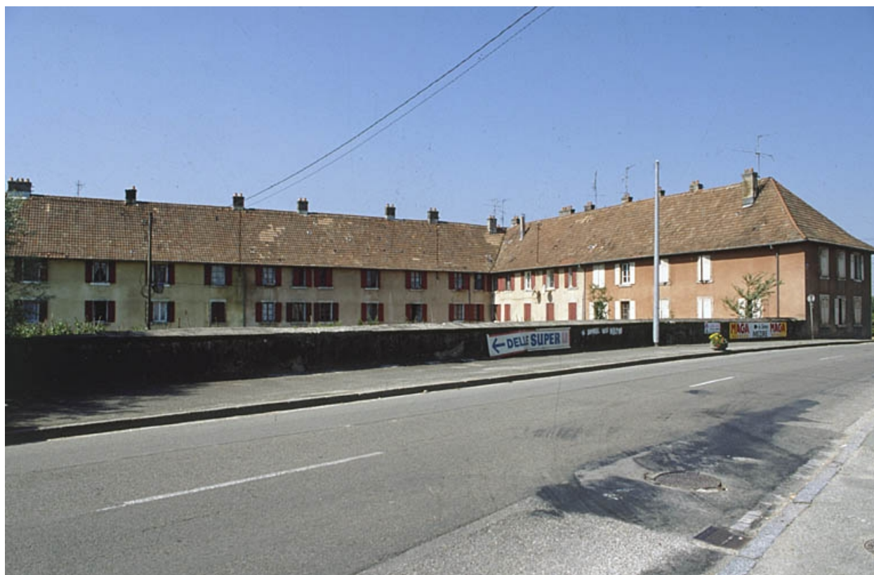
Logement ouvrier dit la Caserne depuis l'est.
