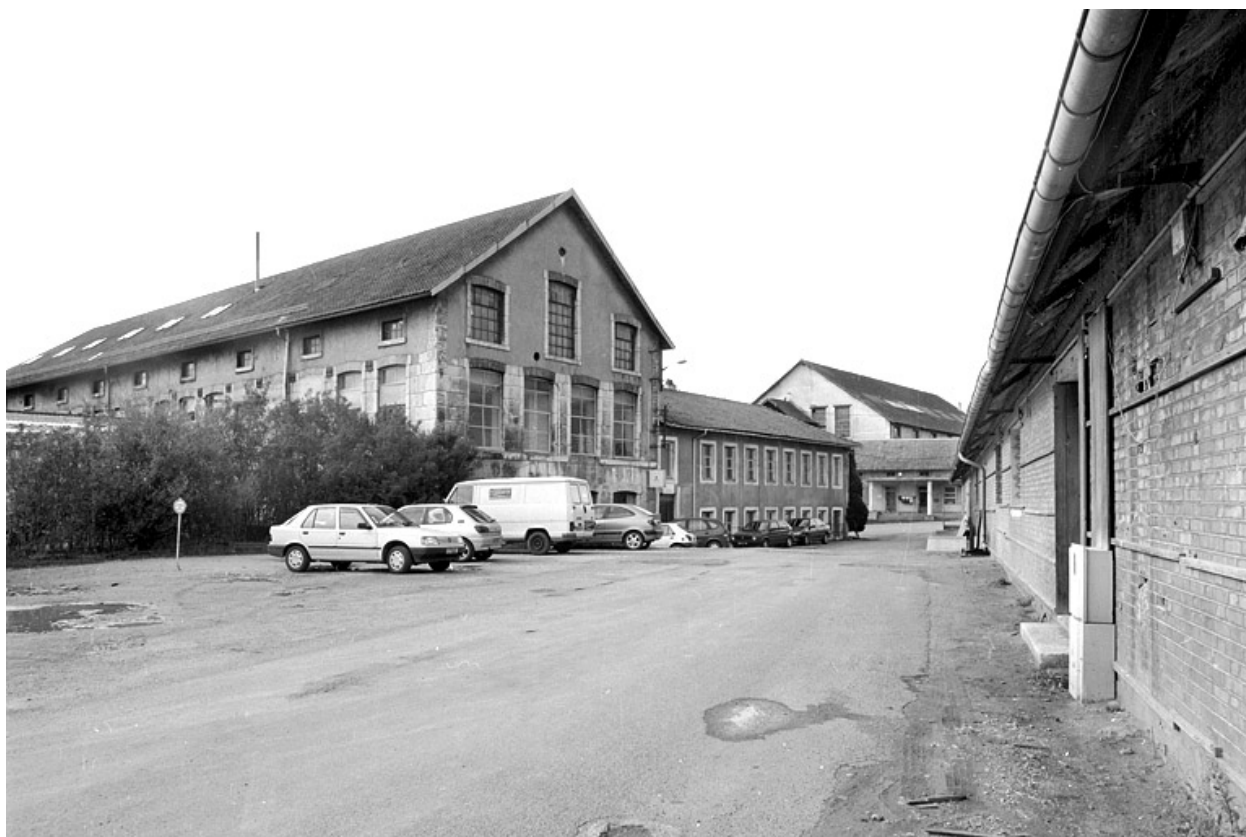
Atelier de fabrication et bureau depuis l'est.
