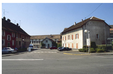
L'entrée des forges. Phot. Yves Sancey IVR43_20019000300ZA
