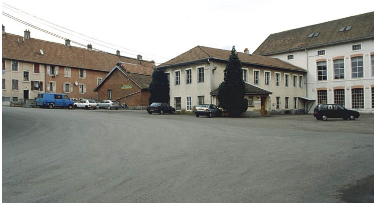
Logement ouvrier et bureau depuis la cour.
