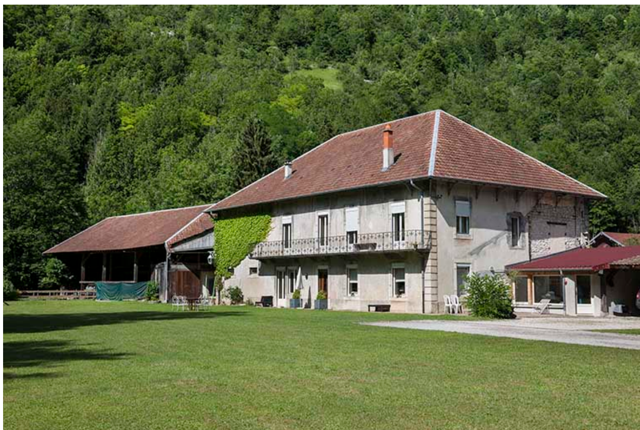
Logement patronal vu de trois quarts droite.
