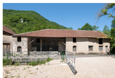
Façade est des écuries et remises. Phot. Jérôme Mongreville IVR43_20152501267NUC4A
