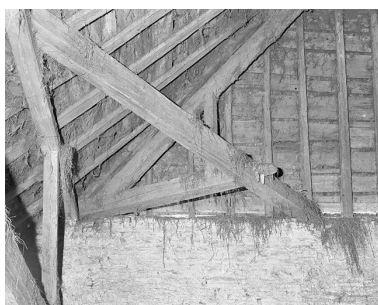
Détail de la charpente au niveau d'une demi-croupe. Phot. Dominique Dominguez IVR43_19792500265X
