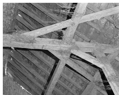
Poteau de charpente latéral d'une ferme. Phot. Dominique Dominguez IVR43_19792500267X
