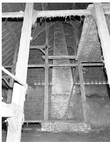
Charpente et cheminée. Phot. Dominique Dominguez IVR43_19792500266X
