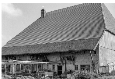
Façade postérieure. Phot. Gilbert Poinot IVR43_19752501351Z
