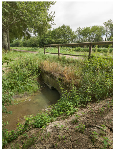
Vue de l'aqueduc.
