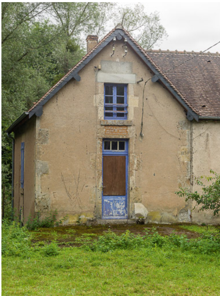
Vue de la maison éclusière.
