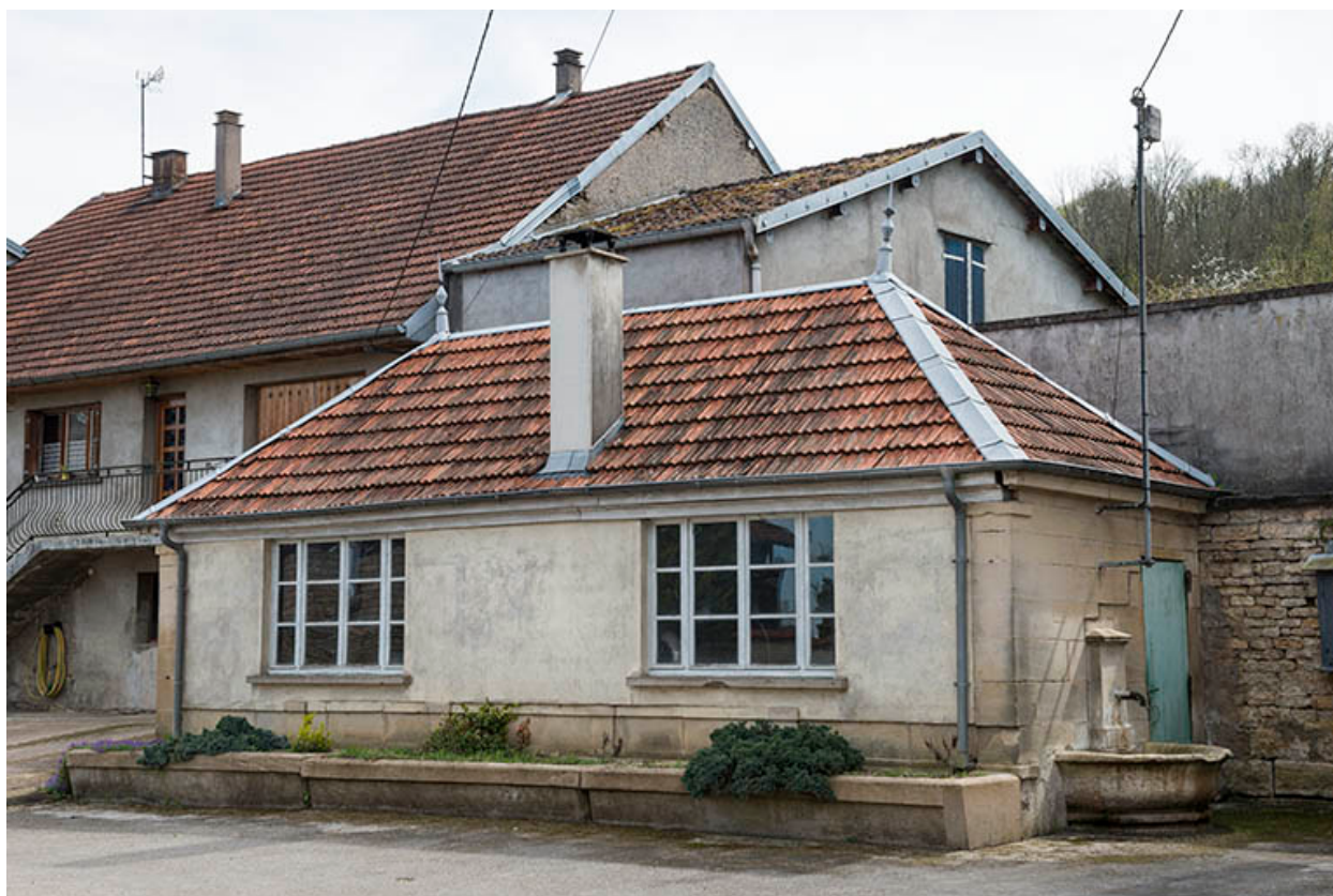
Ancien lavoir transformé en remise.
