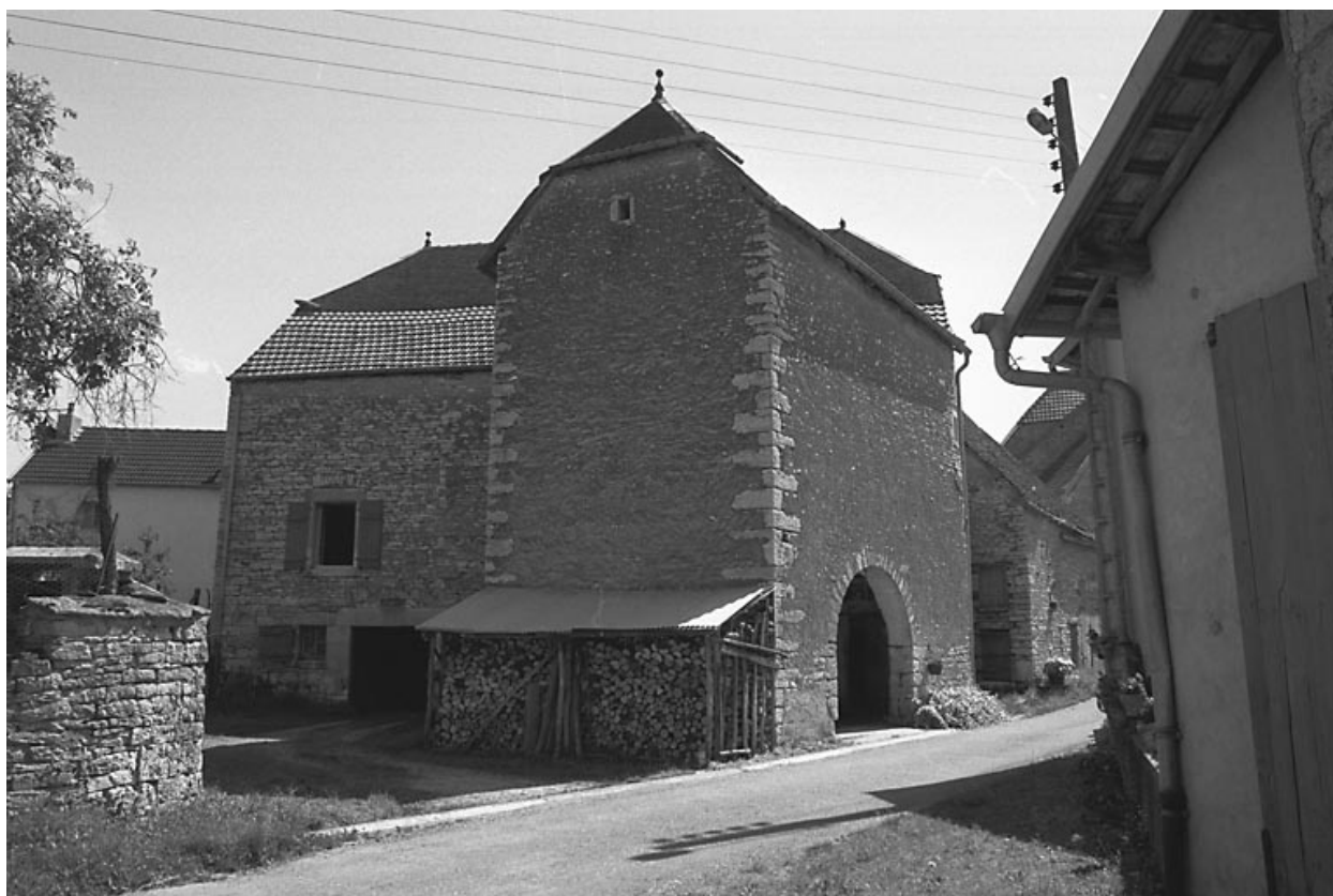
Façade postérieure du bâtiment.
