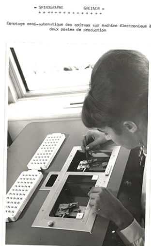
Société Yema : poste de comptage semi-automatique des spiraux, photogr., s.d. [vers 1970]. IVR43_20212500120NUC1A
