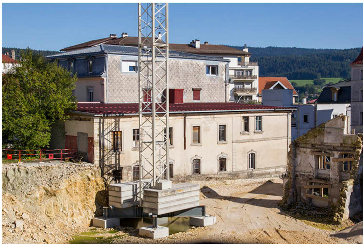
Façades latérale gauche et postérieure.
