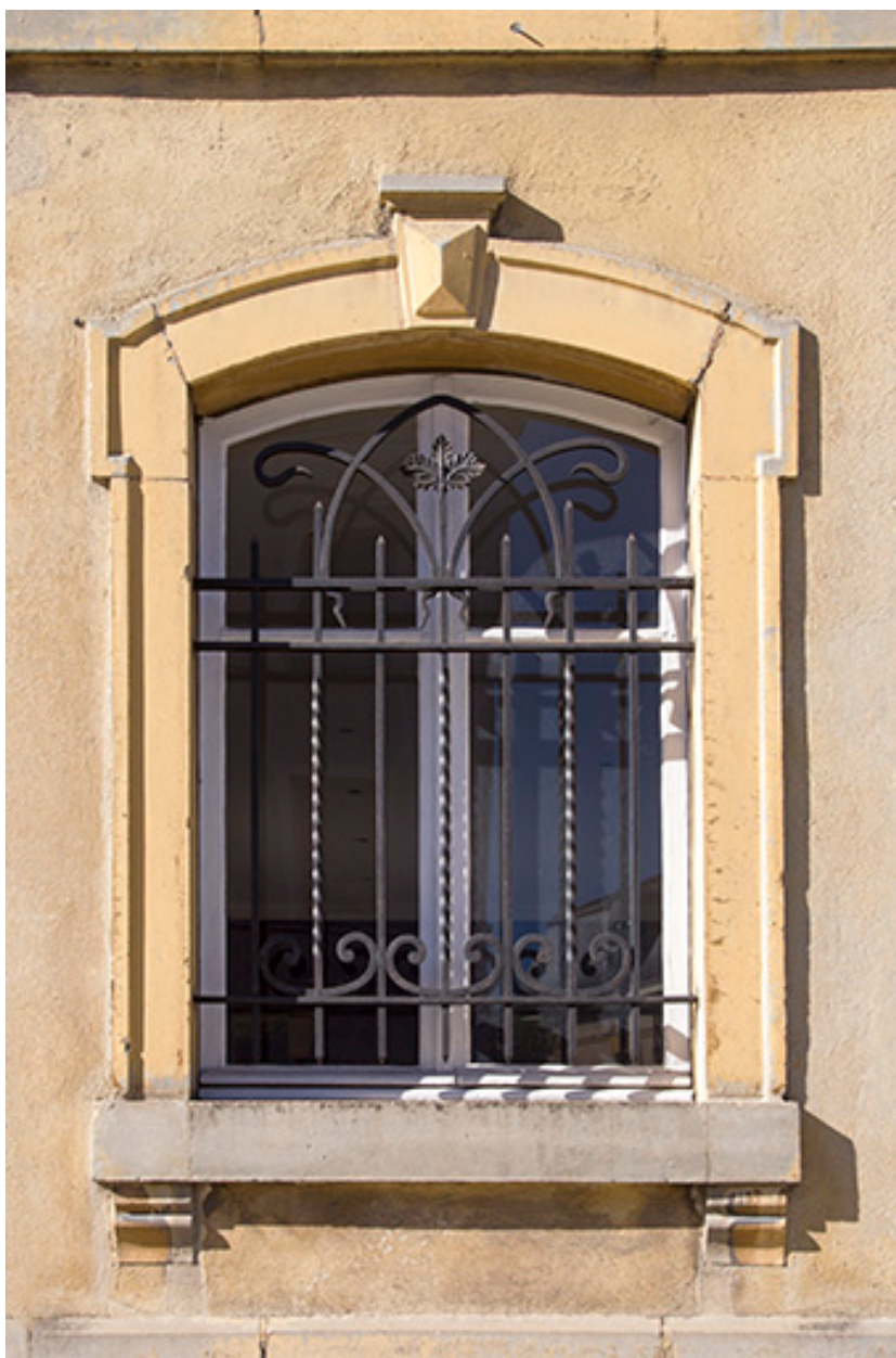
Fenêtre du corps de bâtiment occidental.
