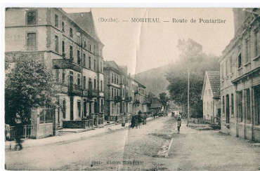
(Doubs). - Morteau. - Route de Pontarlier [la rue René Payot vue de l'est], 1ère moitié 20e siècle [avant 1932]. La façade est visible à droite. Autr. auteur inconnu IVR43_20172501437NUC2A
