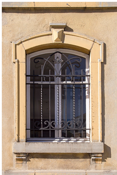
Fenêtre du corps de bâtiment occidental.
