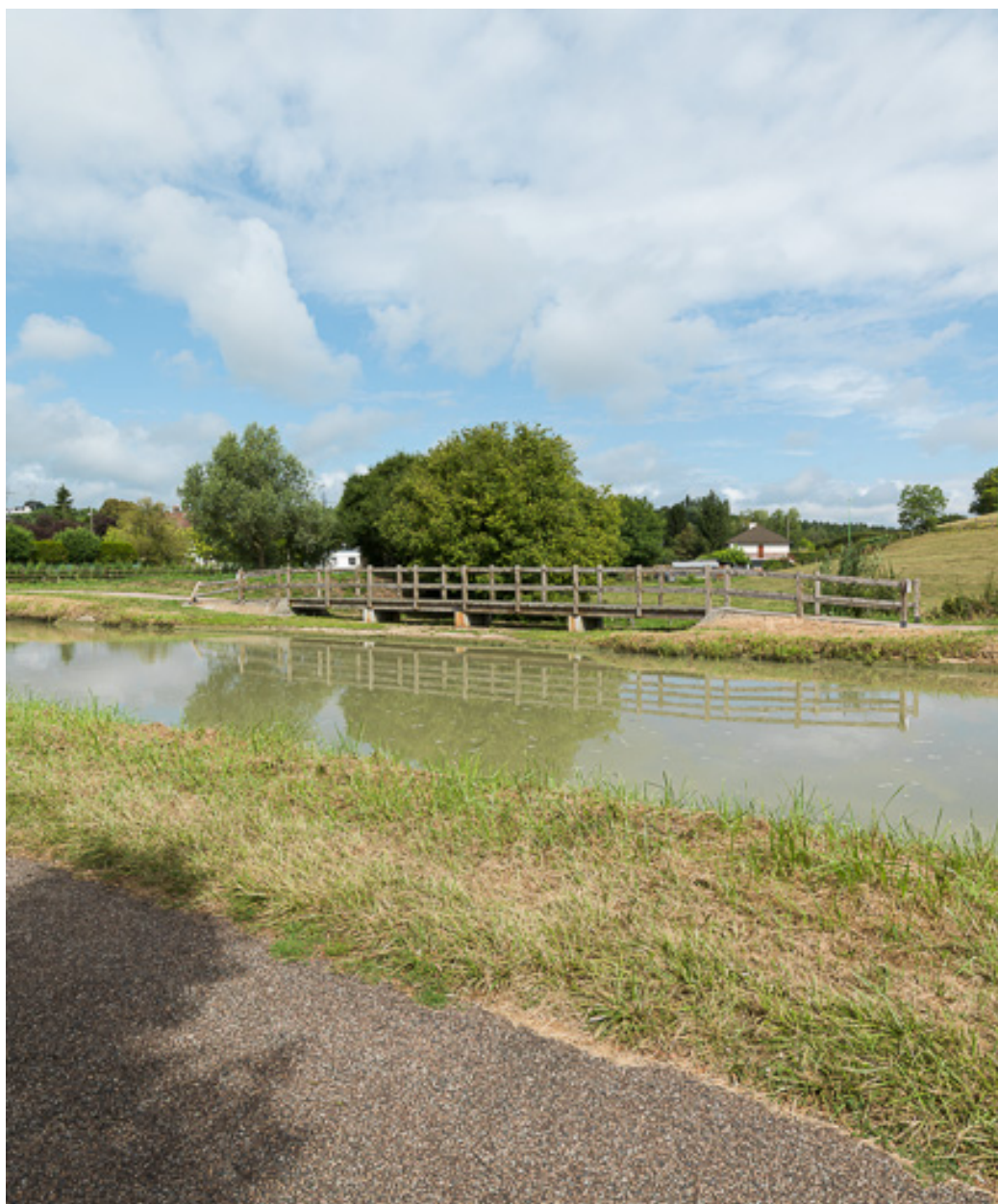
Vue d'ensemble de l'aqueduc.
