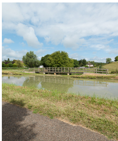
Vue d'ensemble de l'aqueduc. Phot. Pierre-Marie Barbe-Richaud IVR26_20175800234NUC2A
