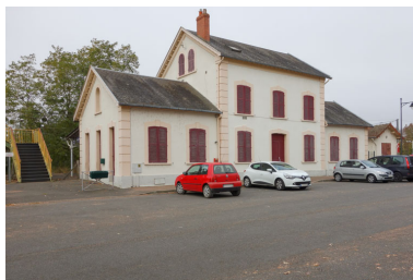
Façade, côté place. Phot. Fabien Dufoulon IVR26_20215800041NUC2A
