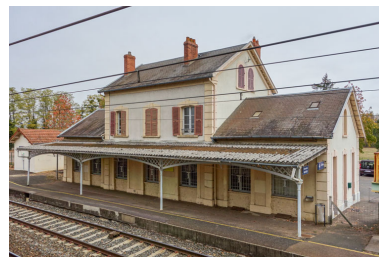
Façade, côté voie ferrée. IVR26_20215800040NUC2A
