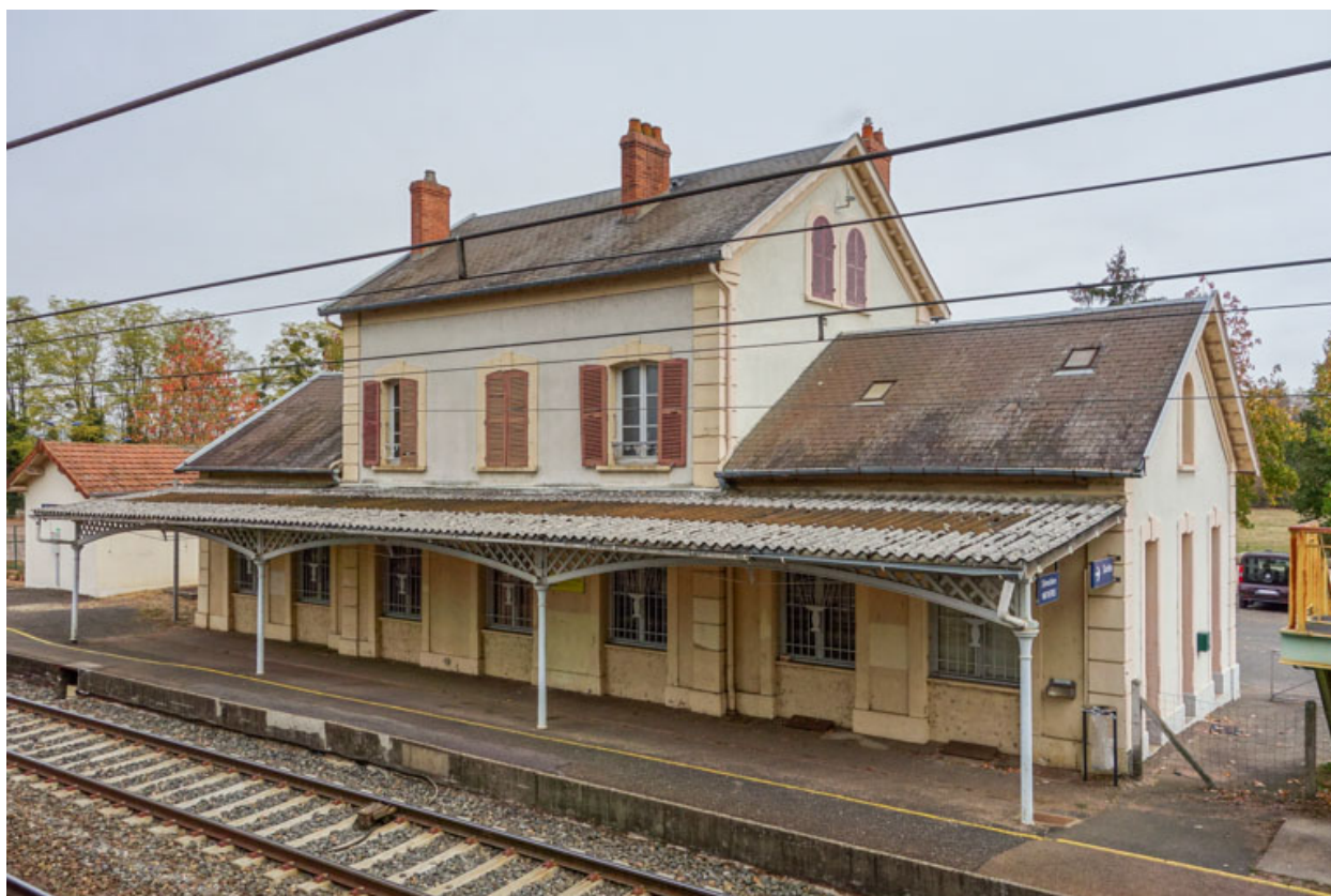
Façade, côté voie ferrée.
