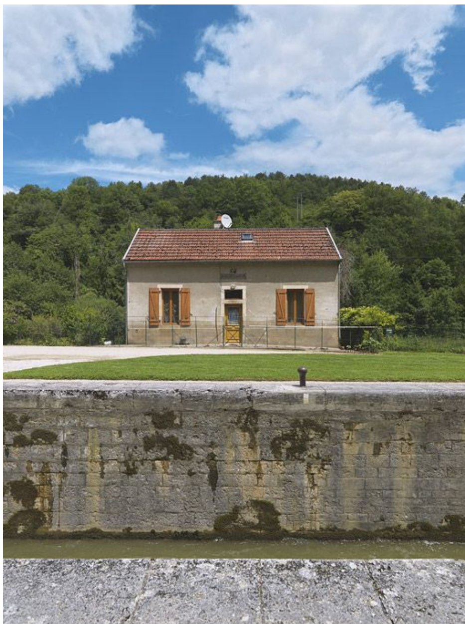
Maison éclusière de face.
