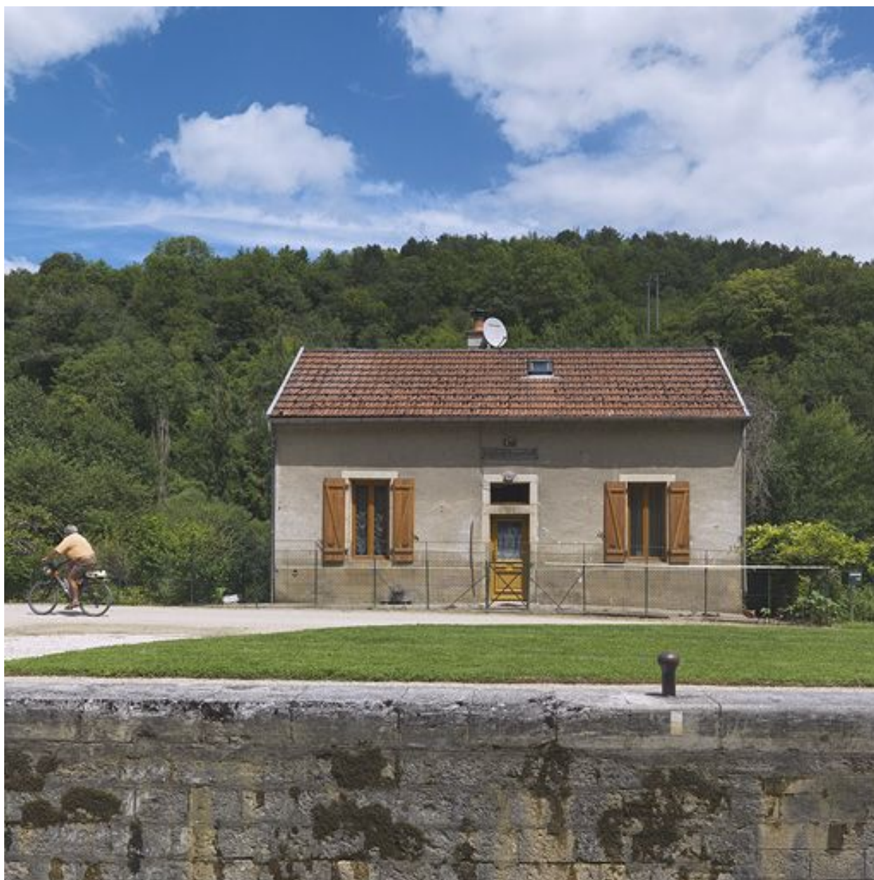
Maison éclusière de face.
