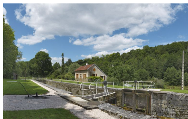
Vue d'aval du site d'écluse 17. Phot. Thierry Kuntz IVR26_20122102243NUC4A
