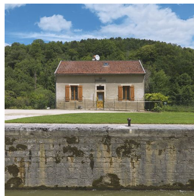
Maison éclésièr de face. Phot. Thierry Kuntz IVR26_20122102246NUC4A
