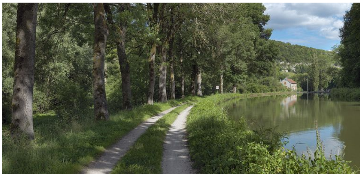
Vue large d'amont du site d'écluse 17.
