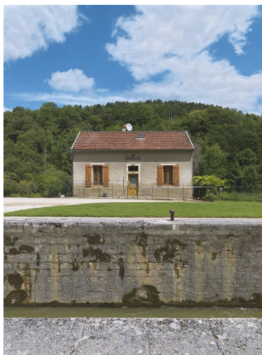
Maison éclésièr de face. Phot. Thierry Kuntz IVR26_20122102244NUC4A
