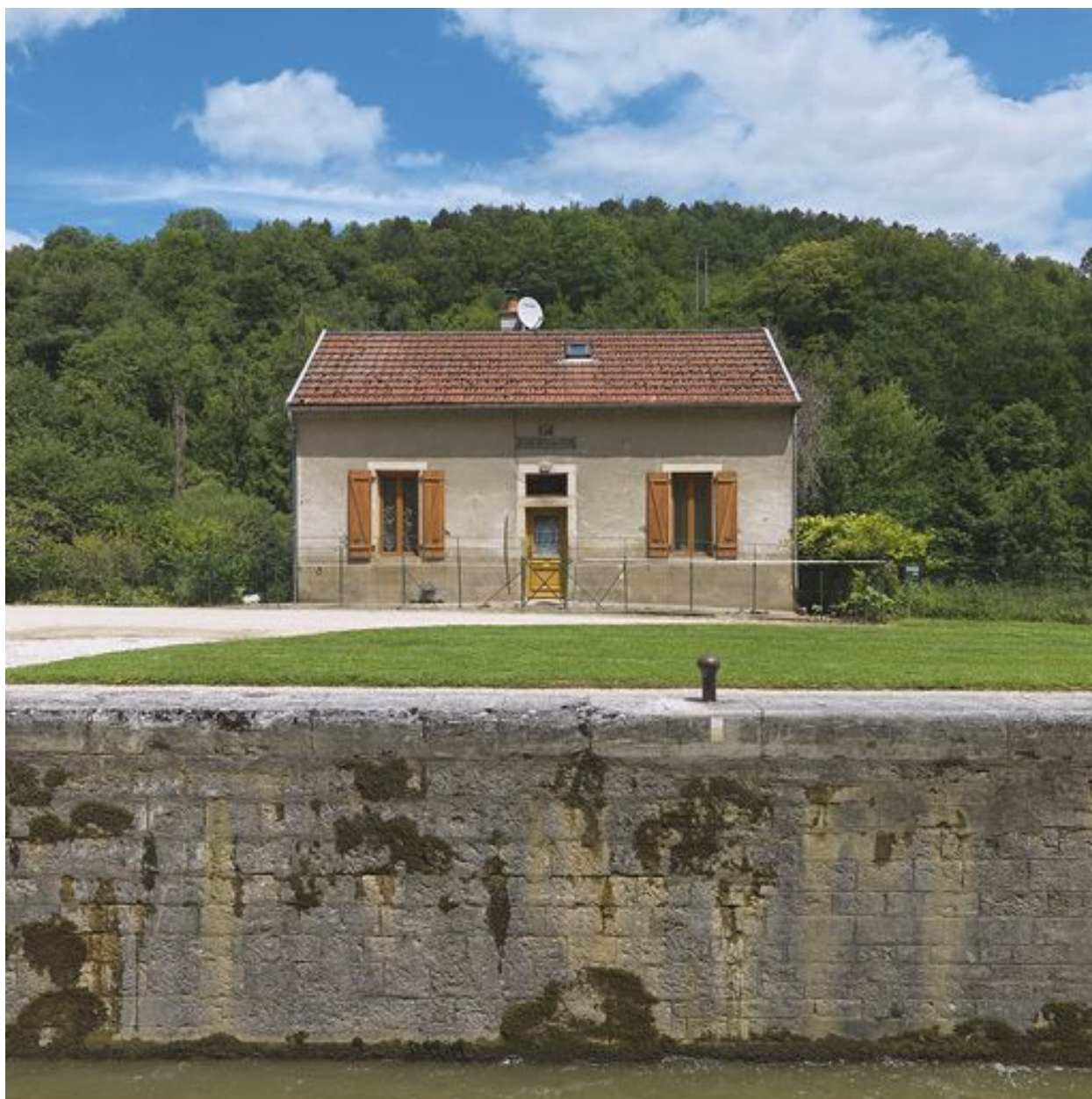
Maison éclusière de face.
