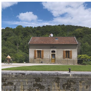
Maison éclésièr de face. Phot. Thierry Kuntz IVR26_20122102245NUC4A
