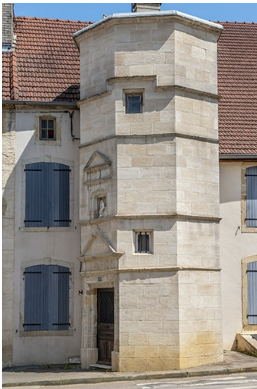
Vue rapprochée de la tour d'escalier.
