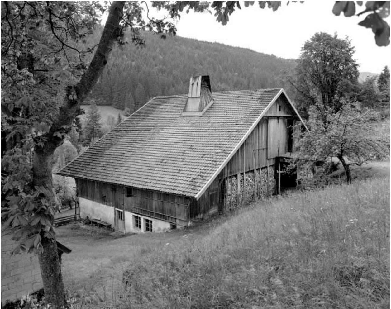
Extérieur : façades postérieure et latérale droite.
