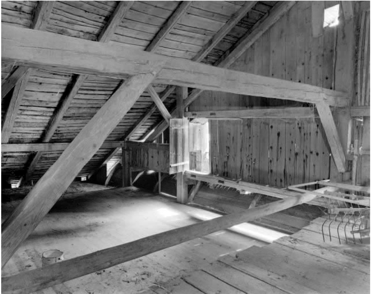
Charpente et lambreques antérieure à surplomb cintré.
