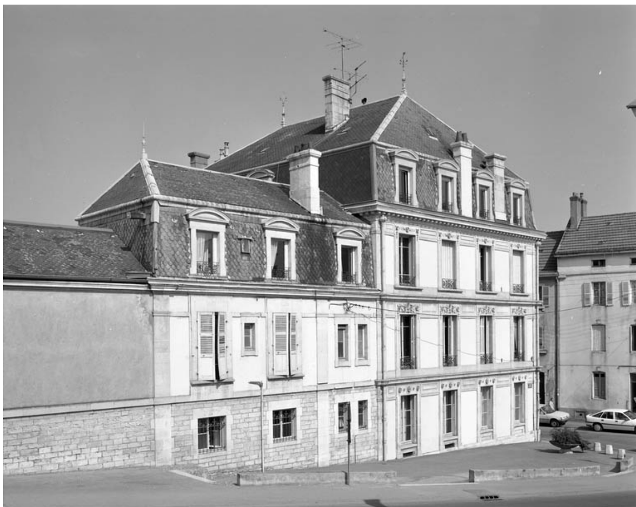
façade latérale, de trois quarts gauche.
