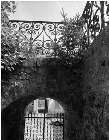
Détail du parapet de l'escalier du jardin. Phot. Yves Sancey IVR43_19897000319X
