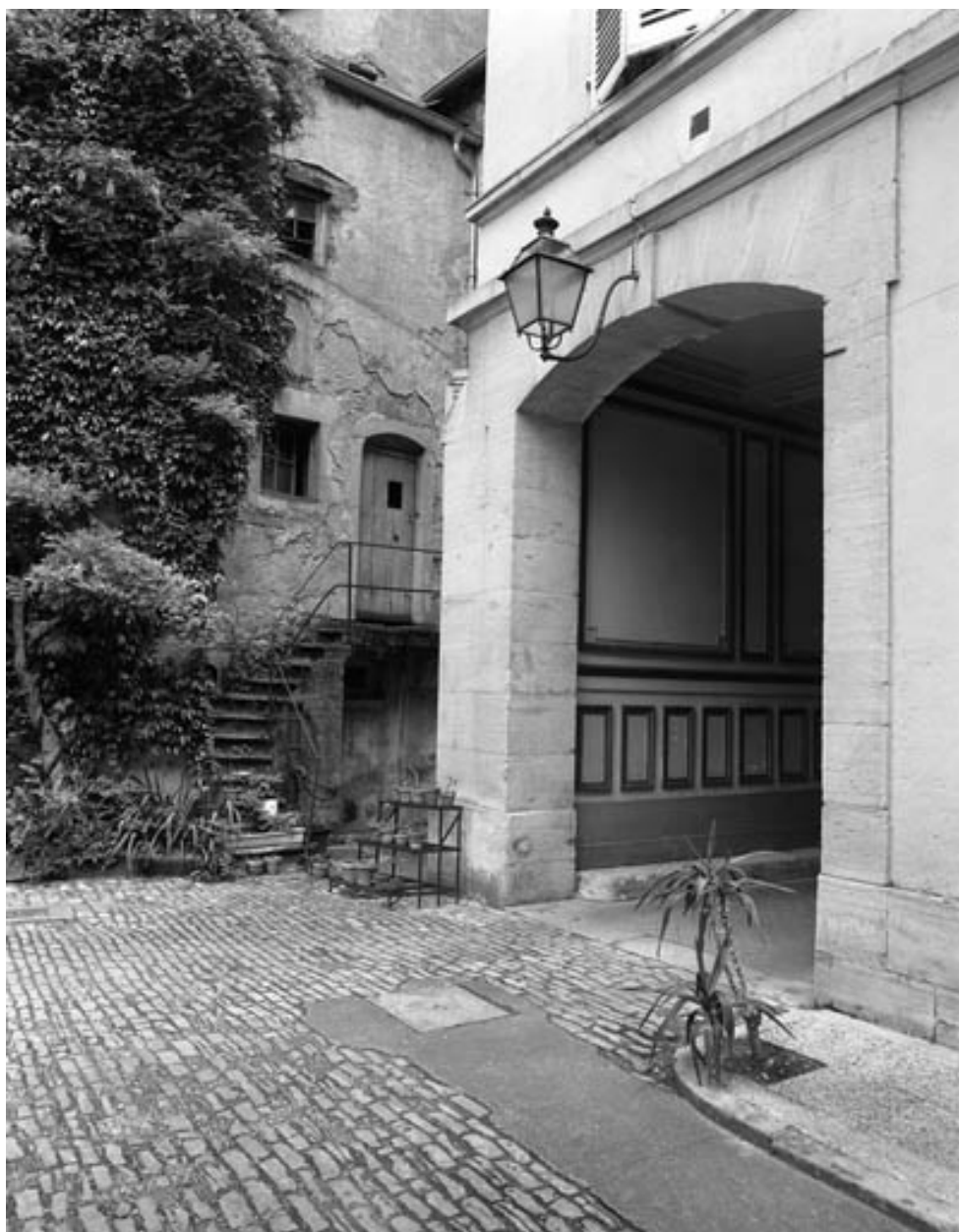
Le passage couvert, côté cour.
