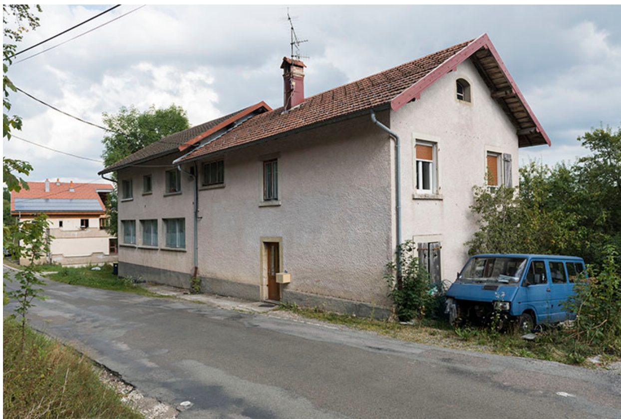
Façades antérieure et latérale droite.
