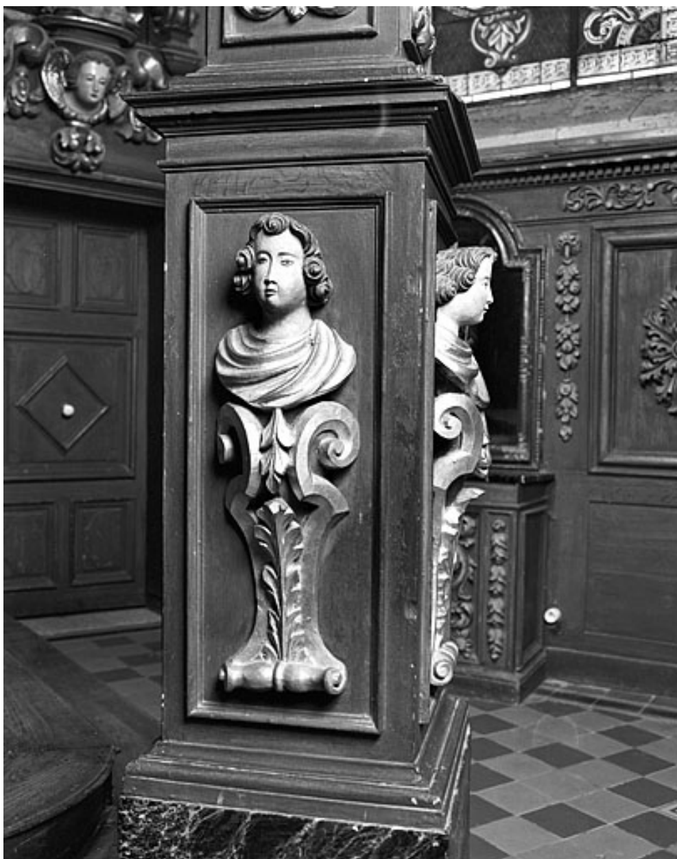
Détail : décor des piédestaux du baldachin.
