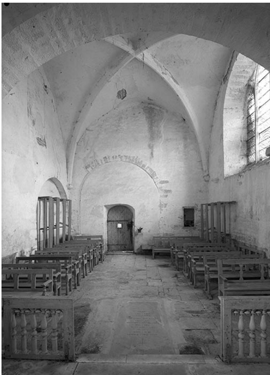
Nef, vue depuis le chœur.
