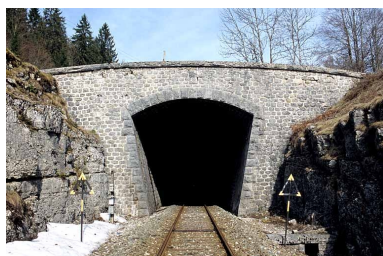
Tête côté La Cluse (sud-est). Phot. Yves Sancey IVR43_20053900294ZA
