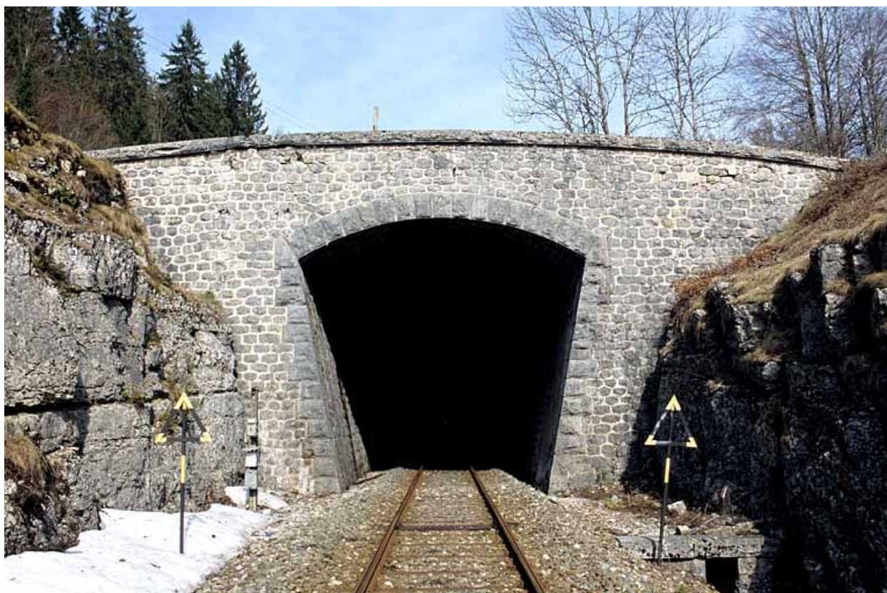
Tête côté La Cluse (sud-est).
