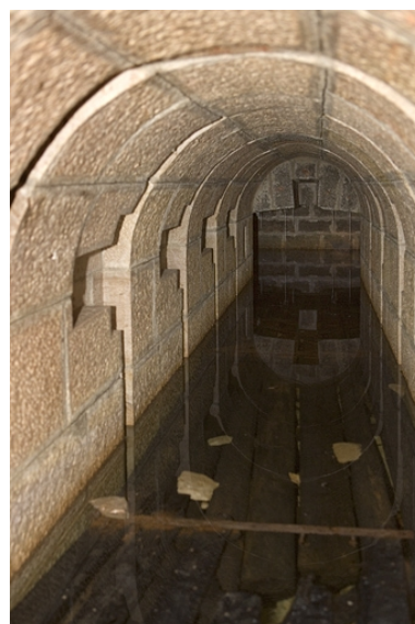
Chambres de mine centrale : galerie inférieure. Phot. Yves Sancey IVR43_20073900336NUCA
