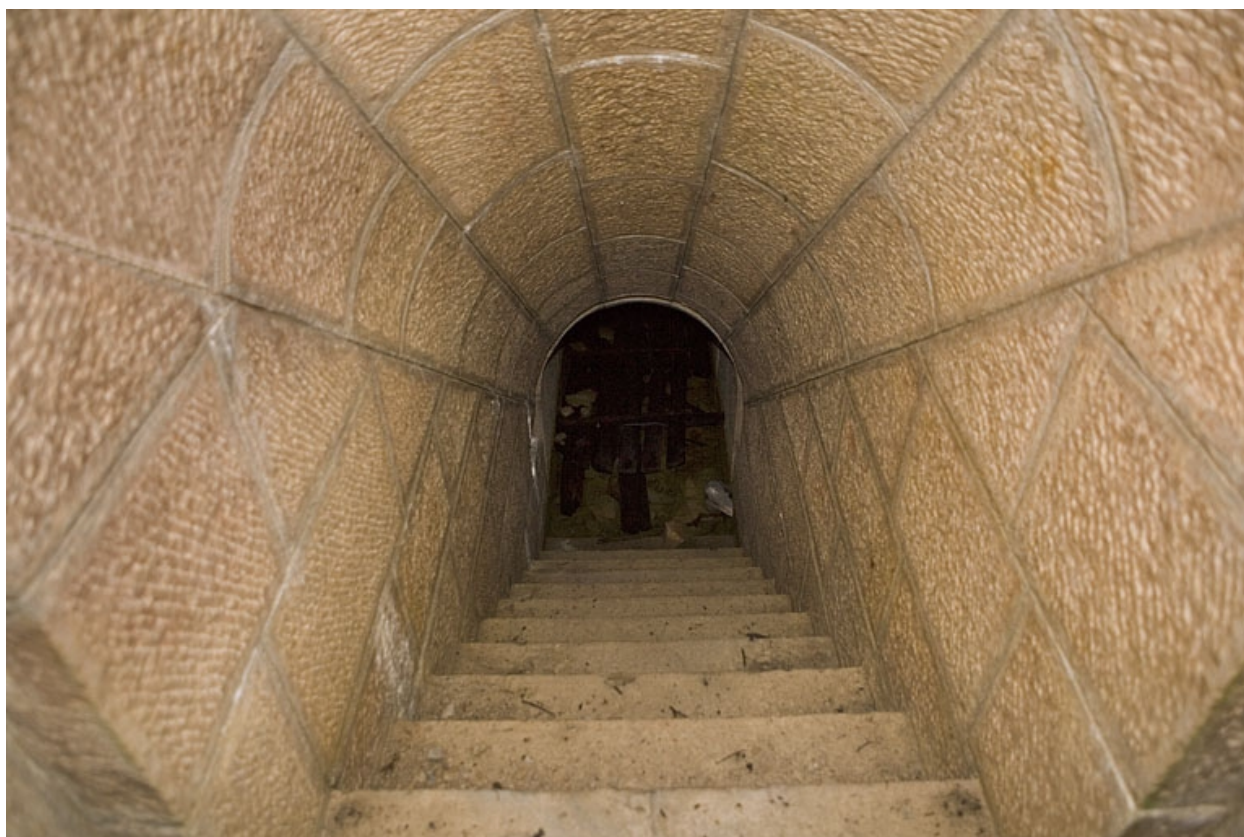
Chambres de mine centrale : escalier.
