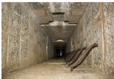
Chambres de mine sud-ouest : intérieur du puits. Phot. Yves Sancey IVR43_20073900331NUCA
