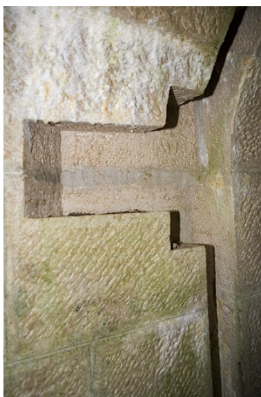
Chambres de mine sud-ouest : encoche creusée dans le mur. Phot. Yves Sancey IVR43_20073900332NUCA
