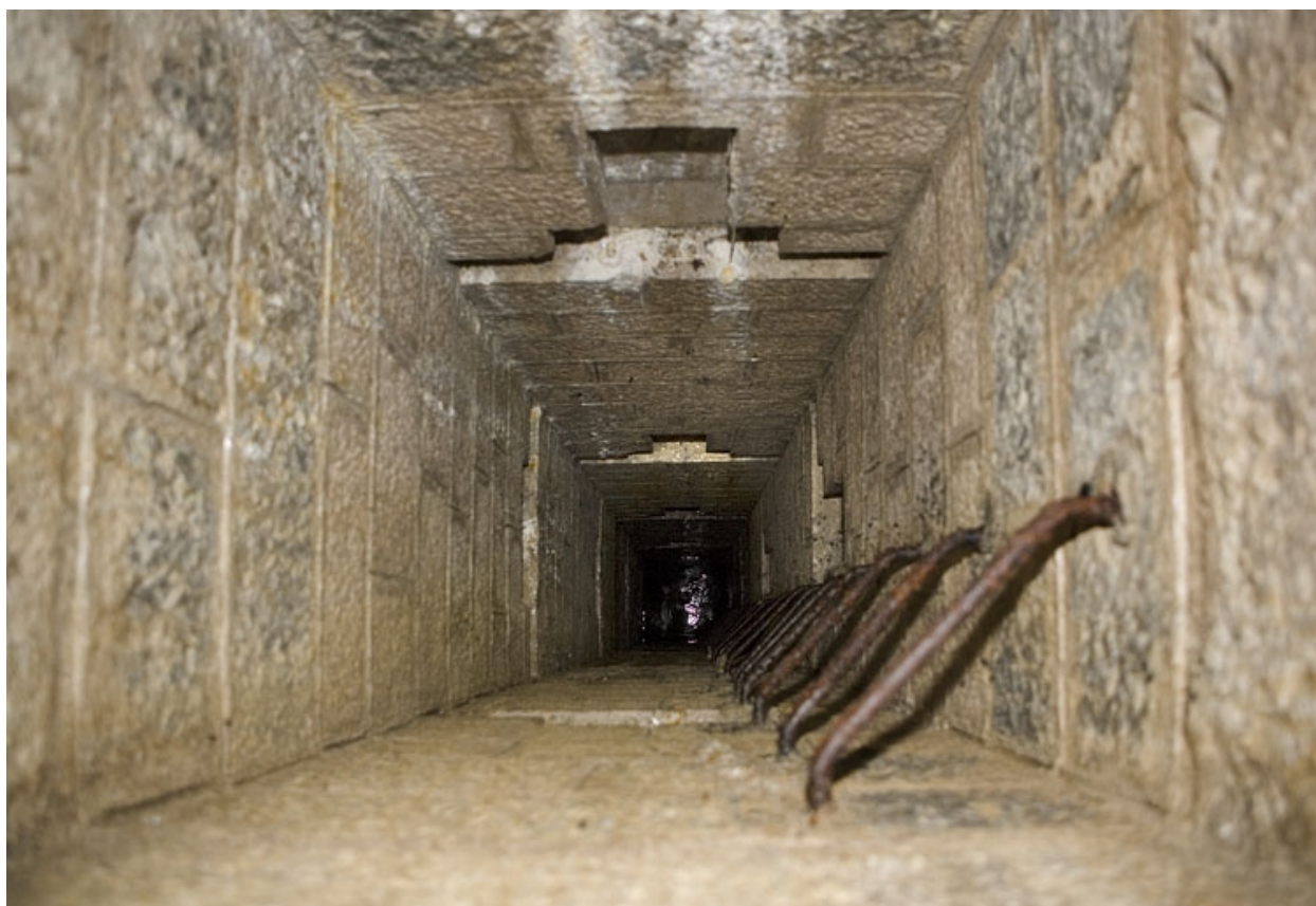
Chambres de mine sud-ouest : intérieur du puits.
