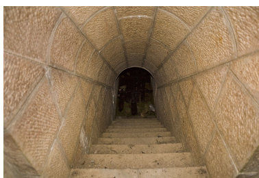
Chambres de mine centrale : escalier. Phot. Yves Sancey IVR43_20073900335NUCA
