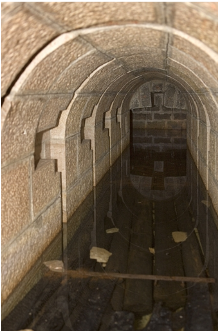
Chambres de mine centrale : galerie inférieure.
