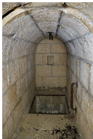
Chambres de mine sud-ouest : fond de la galerie et puits. Phot. Yves Sancey IVR43_20073900329NUCA
