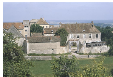
Vue générale Phot. Yves Sancey IVR43_19857000160XA
