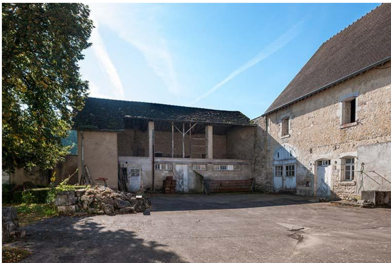
Dépendances situées au sud-ouest de la cour
