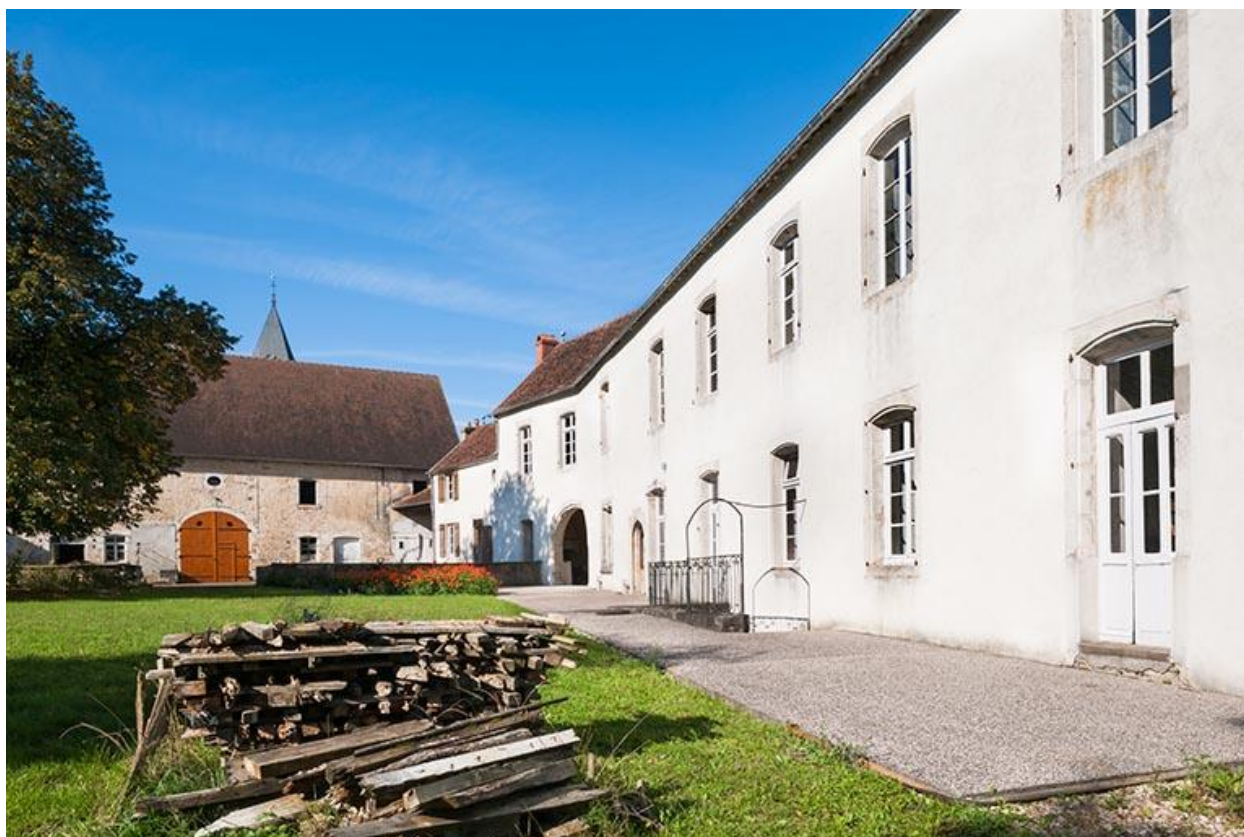
Vue d'ensemble sud-est
