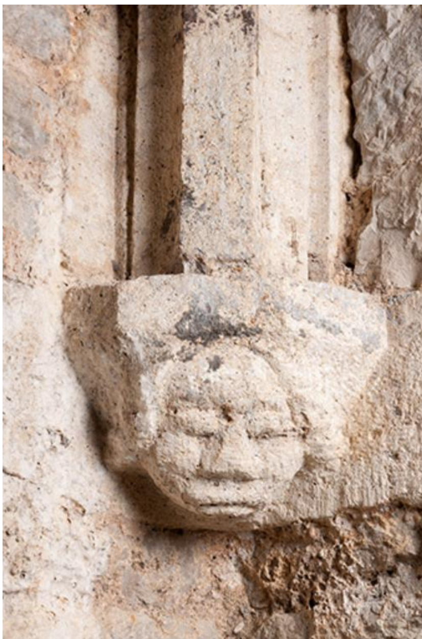
Détail d'un culot de retombée de la voûte sur croisées d'ogives
