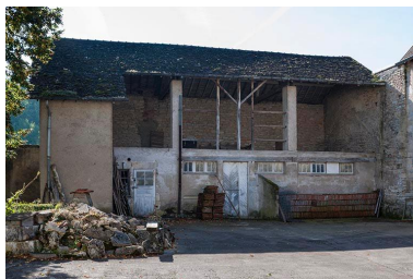
Dépendances situées au sud-ouest de la cour Phot. Jérôme Mongreville IVR43_20137000325NUCA
