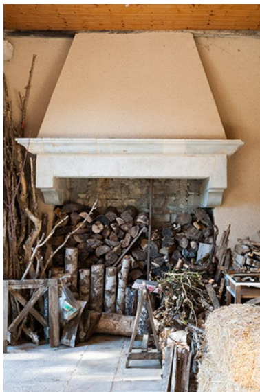
Cheminée située sous le porche Phot. Jérôme Mongreville IVR43_20137000329NUCA
