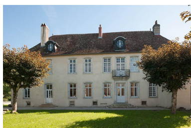
Façade nord Phot. Jérôme Mongreville IVR43_20137000330NUCA
