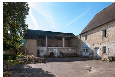
Dépendances situées au sud-ouest de la cour Phot. Jérôme Mongreville IVR43_20137000324NUCA
