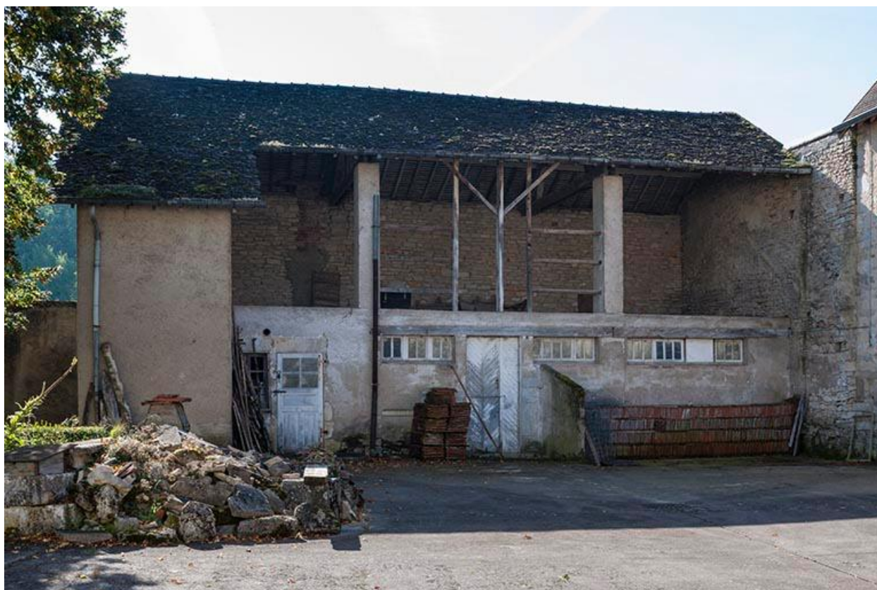
Dépendances situées au sud-ouest de la cour
