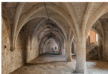
Vue générale de la cave voutée sur croisées d'ogives Phot. Jérôme Mongreville IVR43_20137000337NUCA
