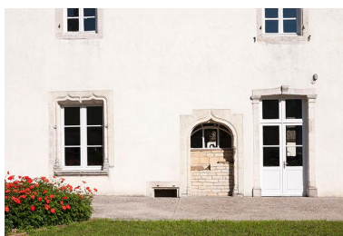
Détail de la façade sud Phot. Jérôme Mongreville IVR43_20137000327NUCA
