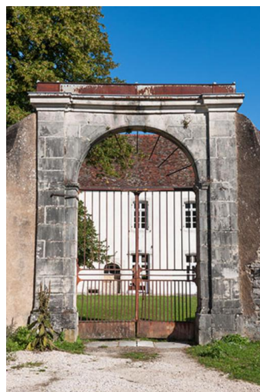
Vue du portail sud Phot. Jérôme Mongreville IVR43_20137000160NUCA
