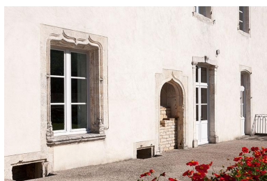
Détail de la façade sud Phot. Jérôme Mongreville IVR43_20137000326NUCA
