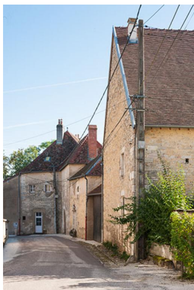
Les bâtiments rue Ménans Phot. Jérôme Mongreville IVR43_20137000315NUCA
