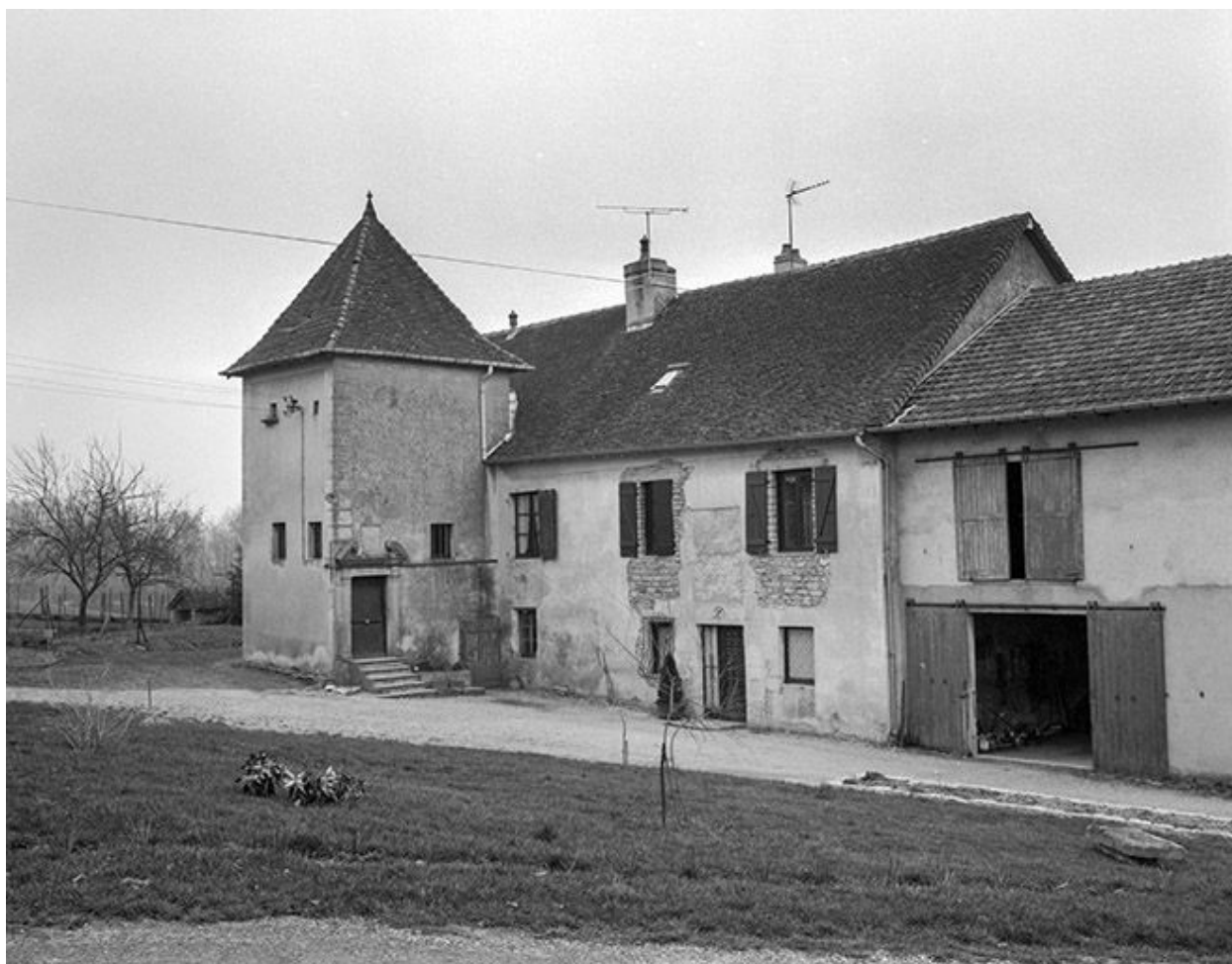
La maison d'habitation.
