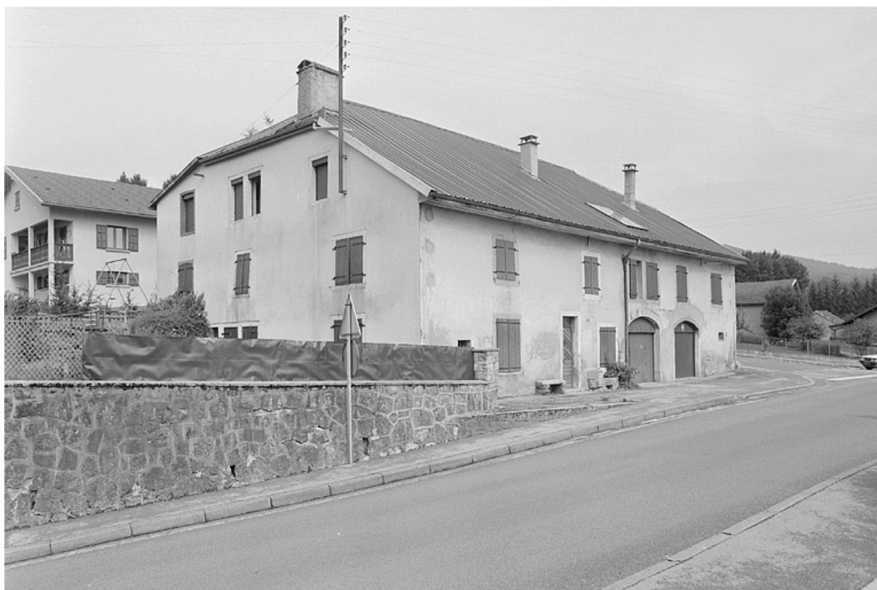
Face sud et façade sur rue.
