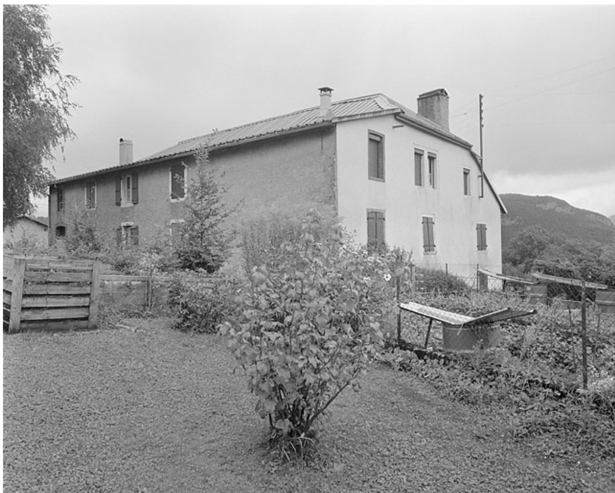
Façade postérieure et face sud.
