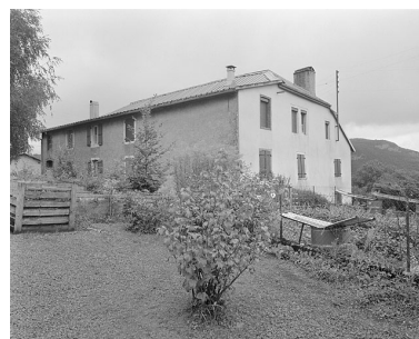
Façade postérieure et face sud.
