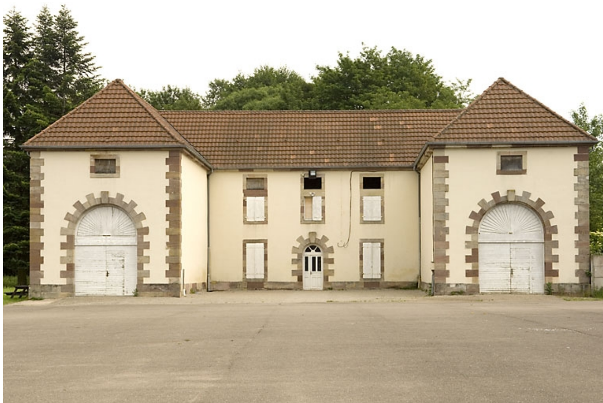
Ecuries et remises. Vue de face.
