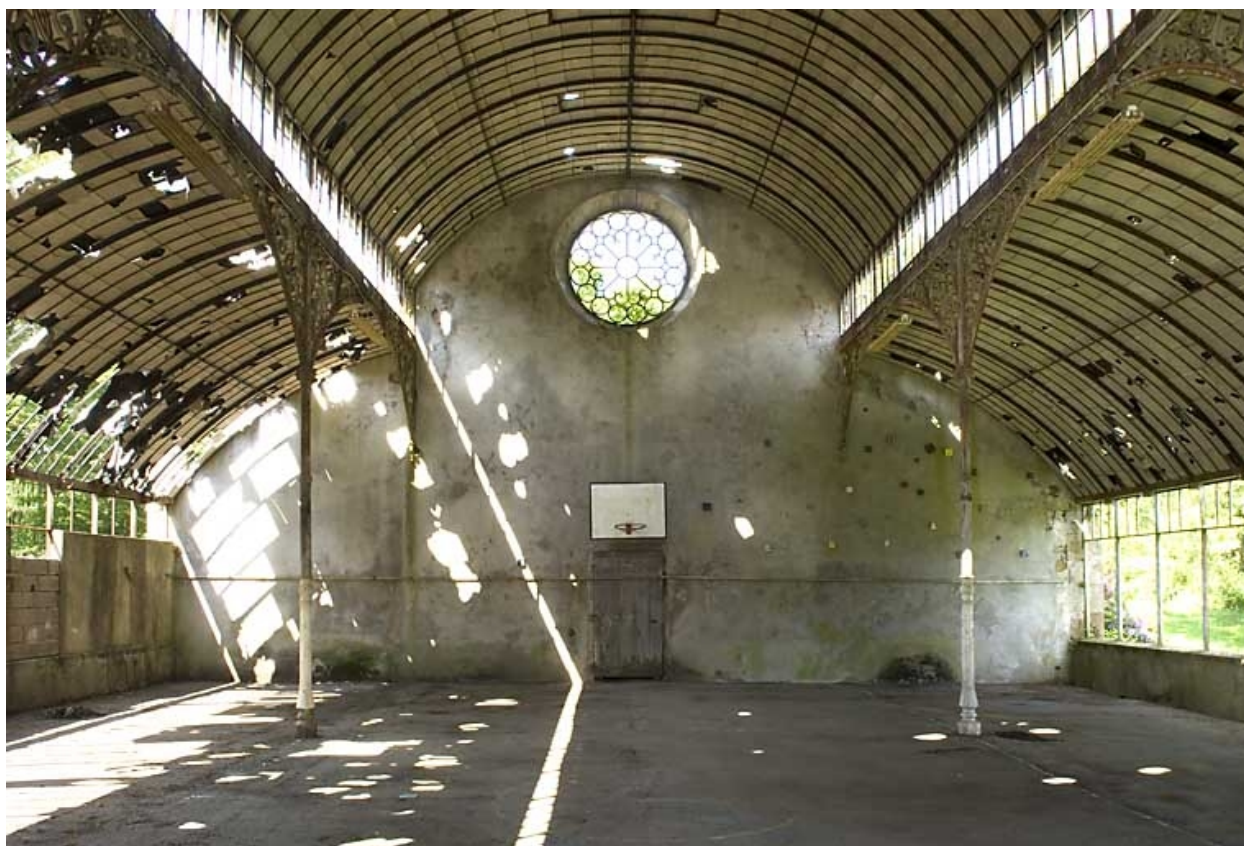
Intérieur de la serre. Vue depuis l'est.
