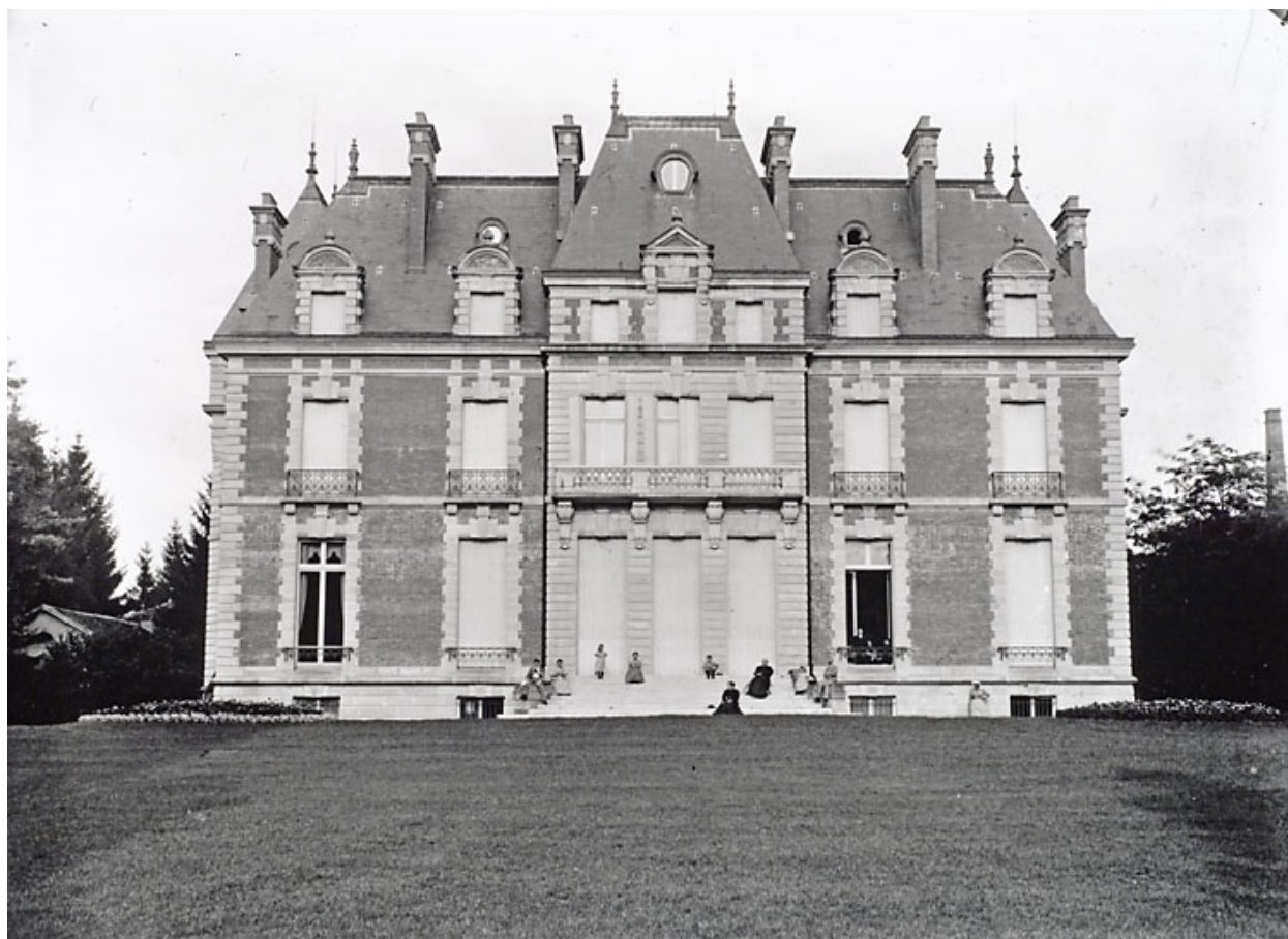
Façade occidentale de la nouvelle demeure patronale.
