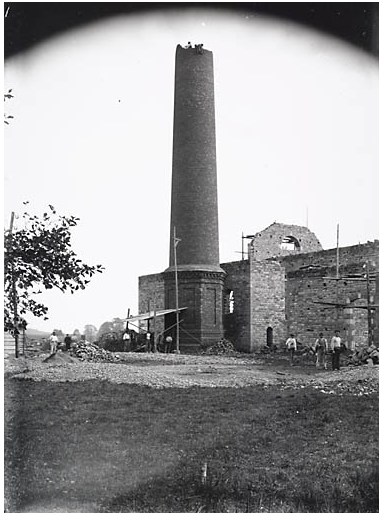
Construction de la cheminée de la nouvelle filature. Phot. Jérôme Mongreville IVR43_20077000372NUCAB
