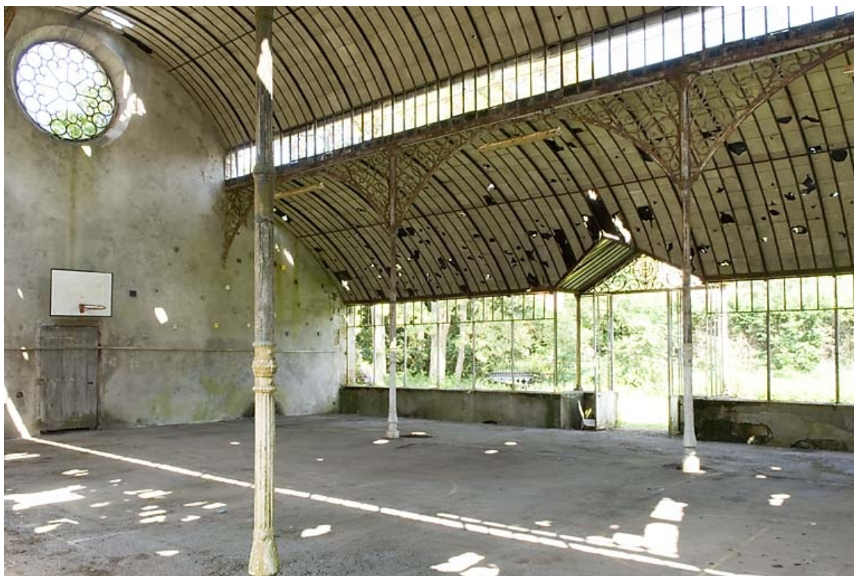
Intérieur de la serre. Vue de côté.
