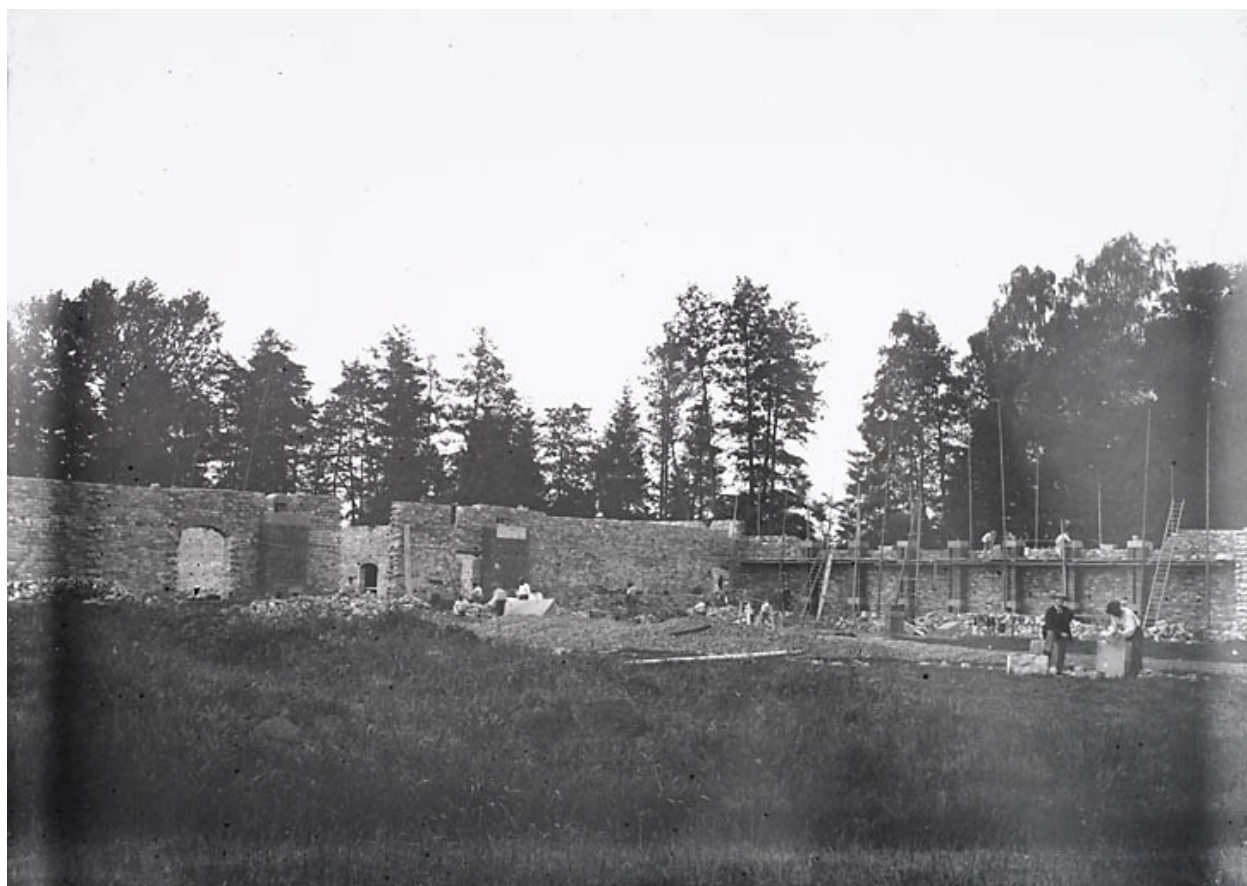
Construction de la nouvelle filature.
