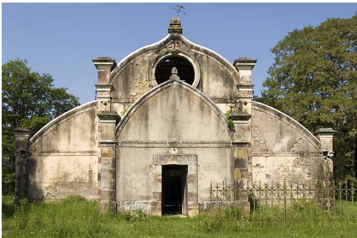
Serre. Mur-pignon est.
