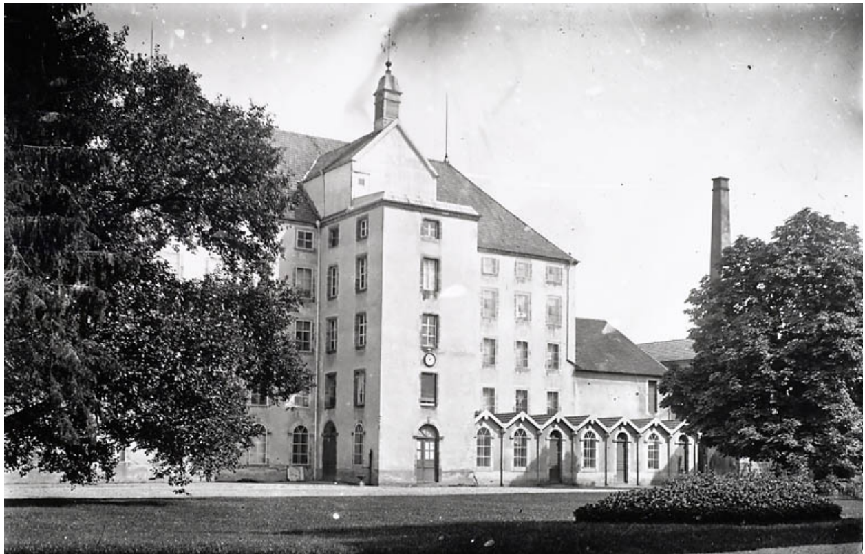
Elévation ouest de l'ancienne filature.
