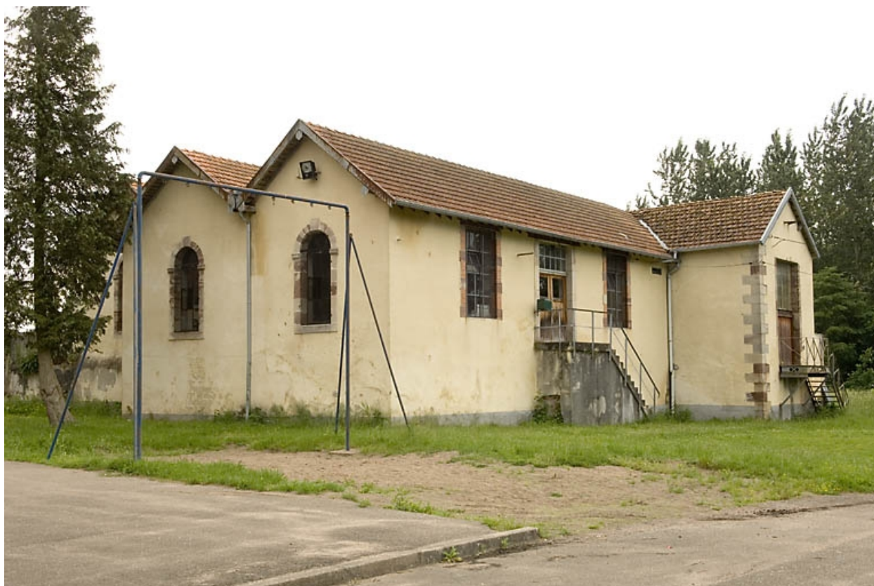
Centrale hydroélectrique. Vue de trois quarts.
