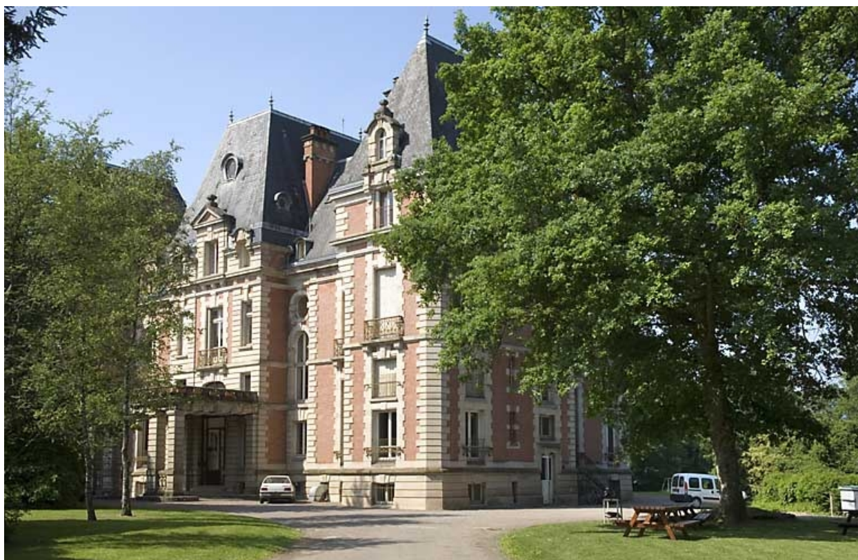
Logement patronal. Vue de trois quarts.
