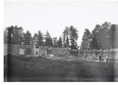
Construction de la nouvelle filature. Phot. Jérôme Mongreville IVR43_20077000370NUCAB
