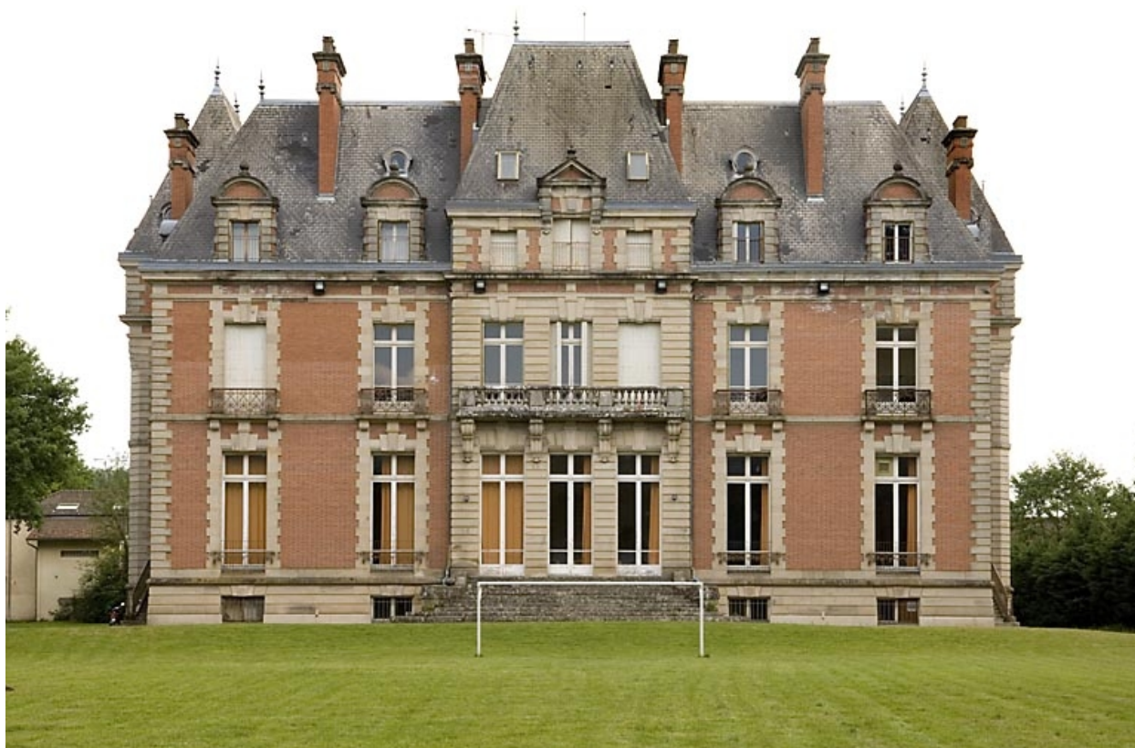
Logement patronal. Façade postérieure.
