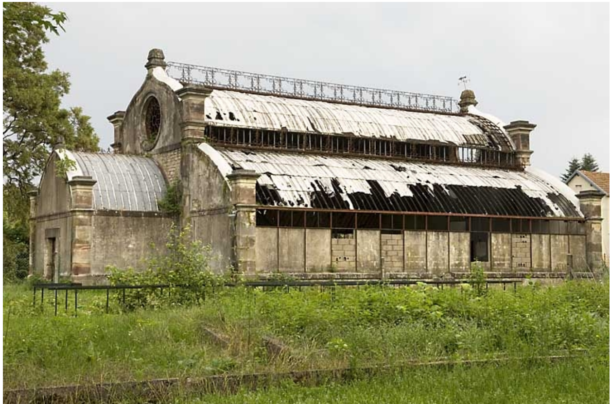
Serre. Façade sud.
