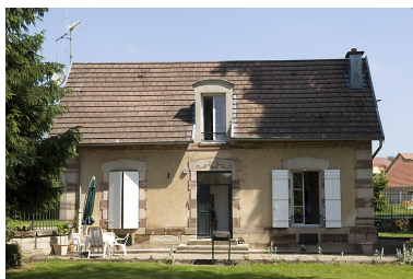
Conciergerie. Phot. Jérôme Mongreville IVR43_20077000353NUCA
