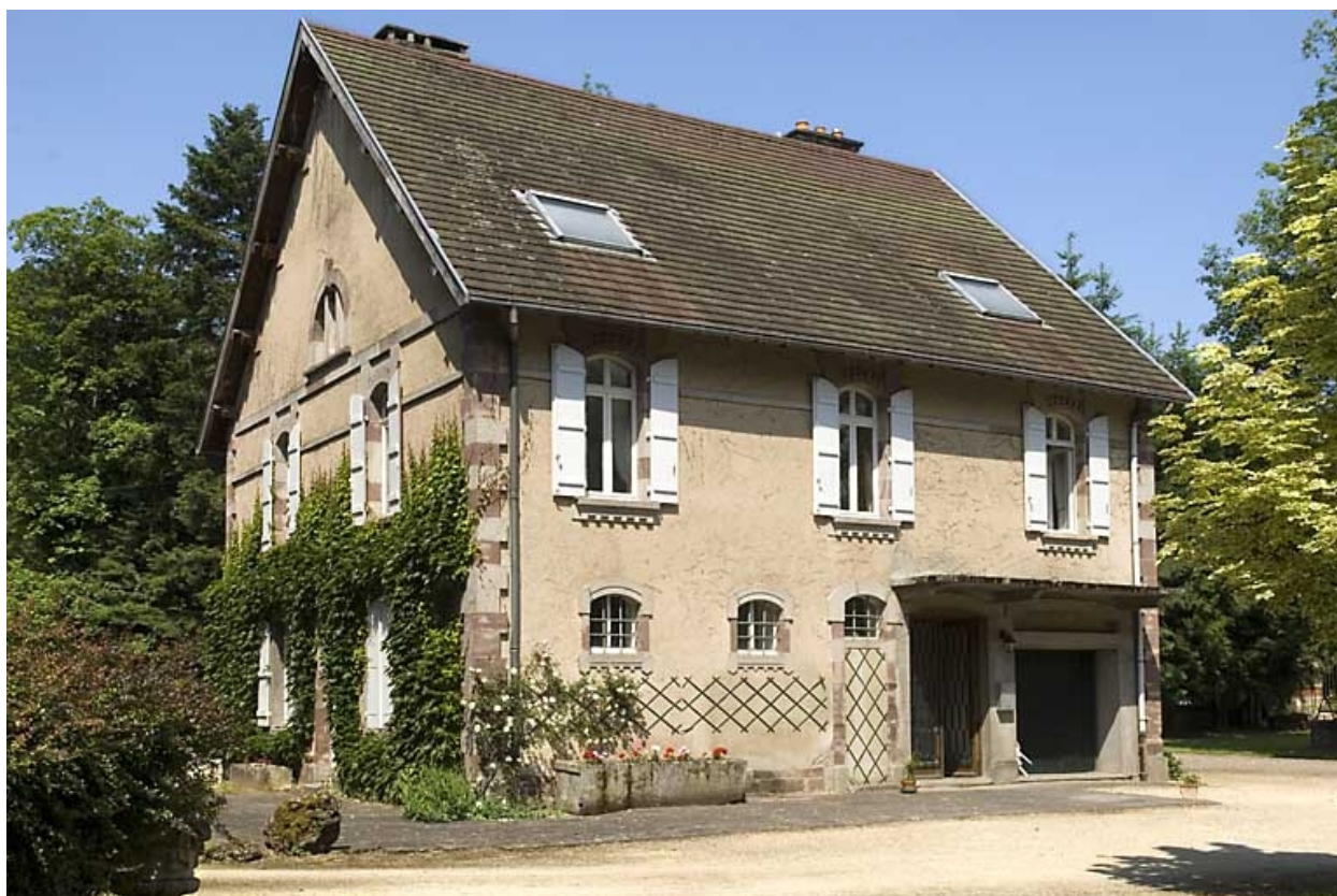
Logement (ancien chenil). Vue de trois quarts.
