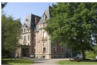
Logement patronal. Vue de trois quarts. Phot. Jérôme Mongreville IVR43_20077000355NUCA
