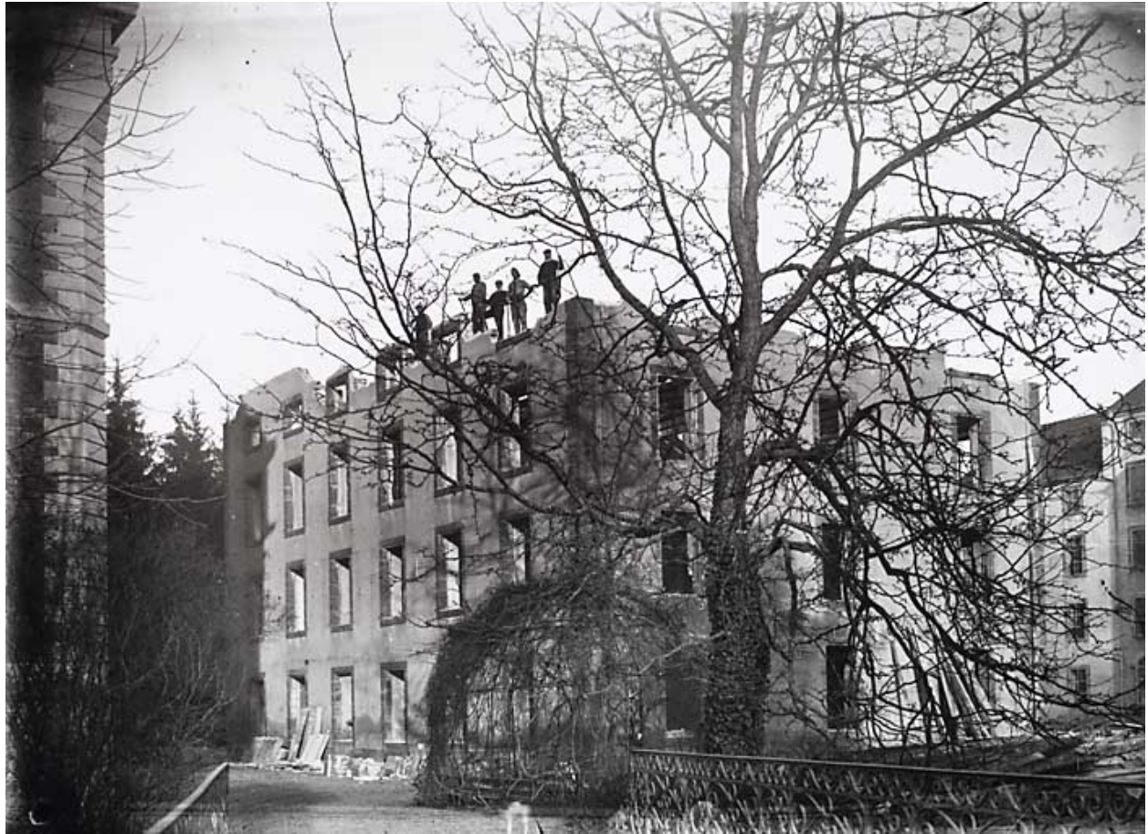
Démolition de l'ancienne filature.
