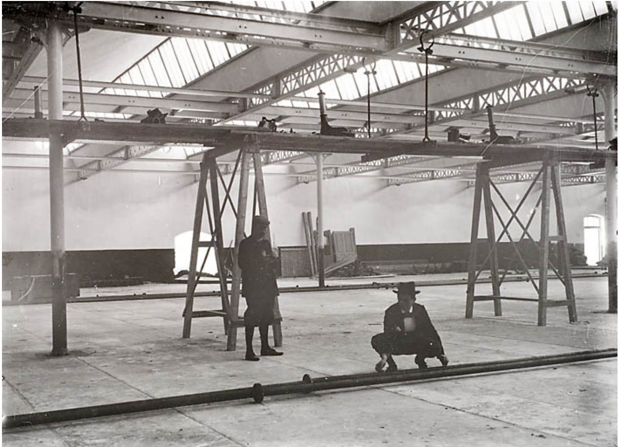
Installation du système de chauffage dans la nouvelle filature.
