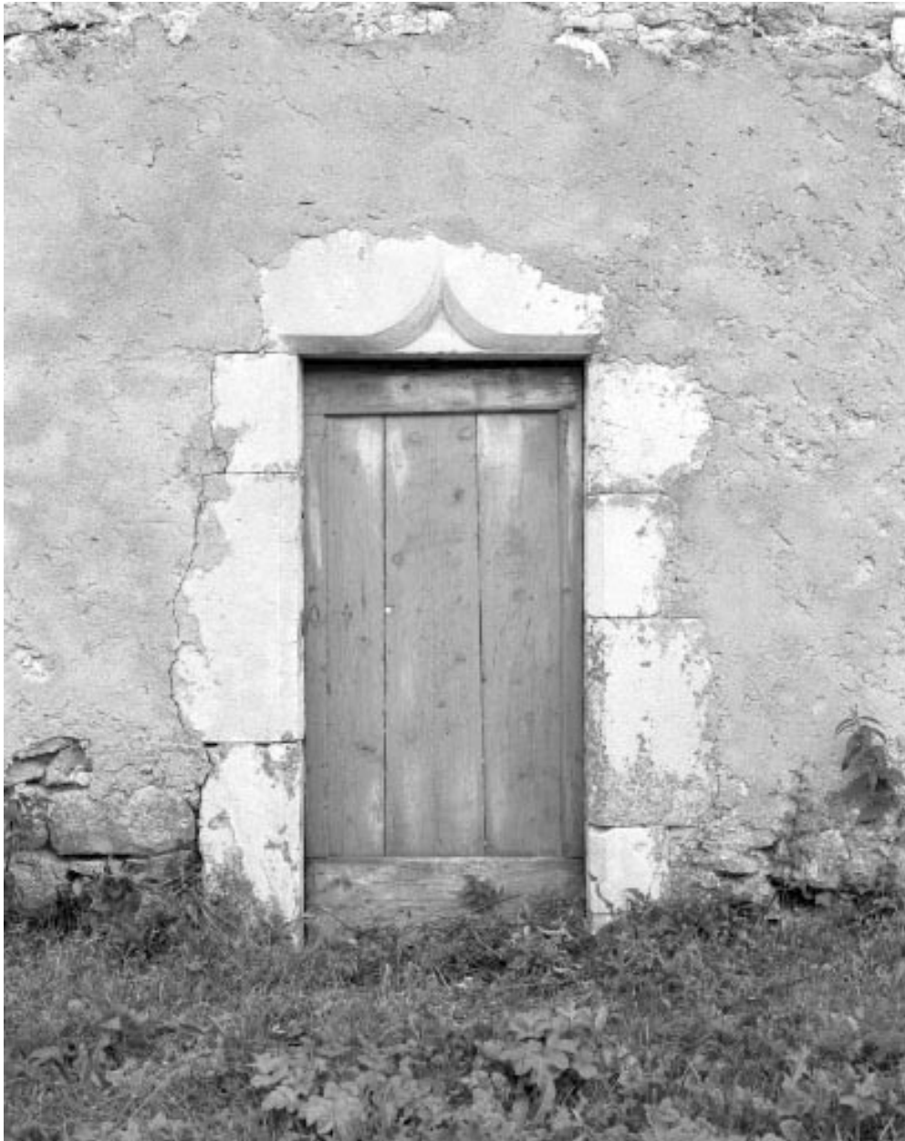
Porte d'accès à l'étable.
