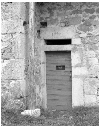
Porte d'accès au logis. Phot. Jérôme Mongreville IVR43_19943900870X
