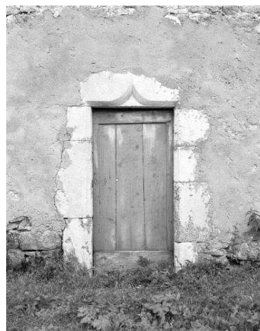
Porte d'accès à l'étable. Phot. Jérôme Mongreville IVR43_19943900869X
