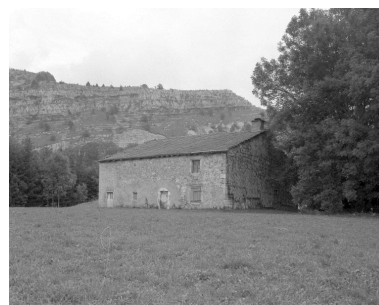
Façade postérieure et face gauche recouverte d'un essentage de tavaillons. Phot. Jérôme Mongreville IVR43_19943900866X
