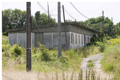
Logement P (en ruines). Phot. Jérôme Mongreville IVR43_20122501809NUC4A
