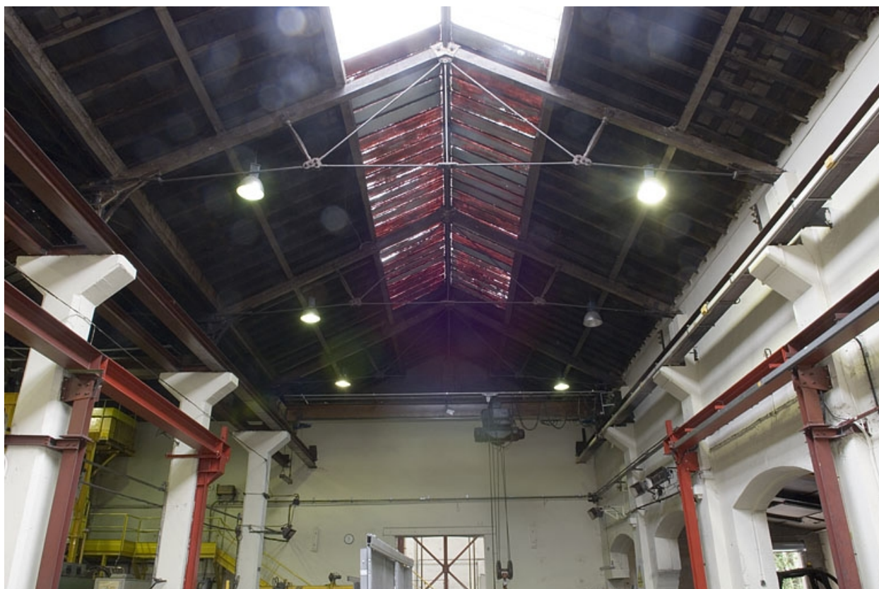
Intérieur de l'atelier et charpente Polonceau.
