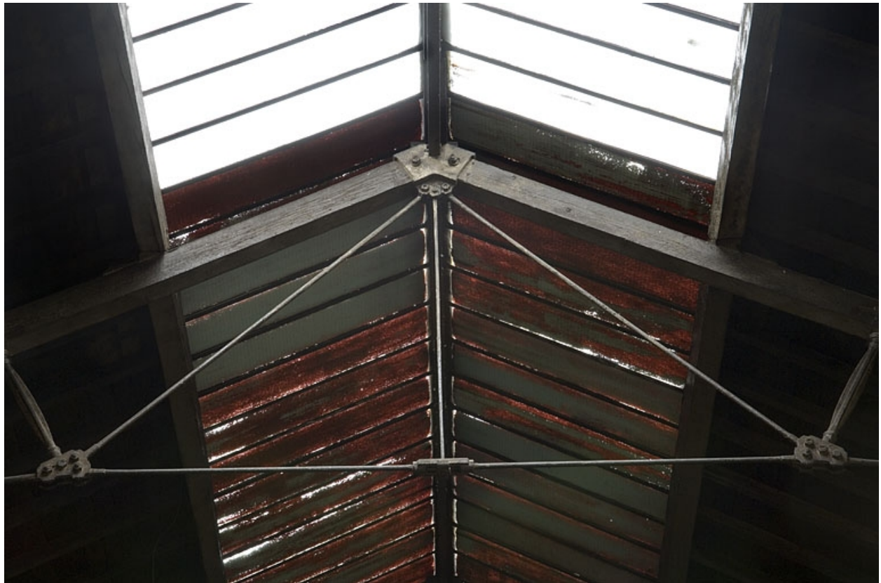
Détail de la charpente Polonceau de l'atelier.
