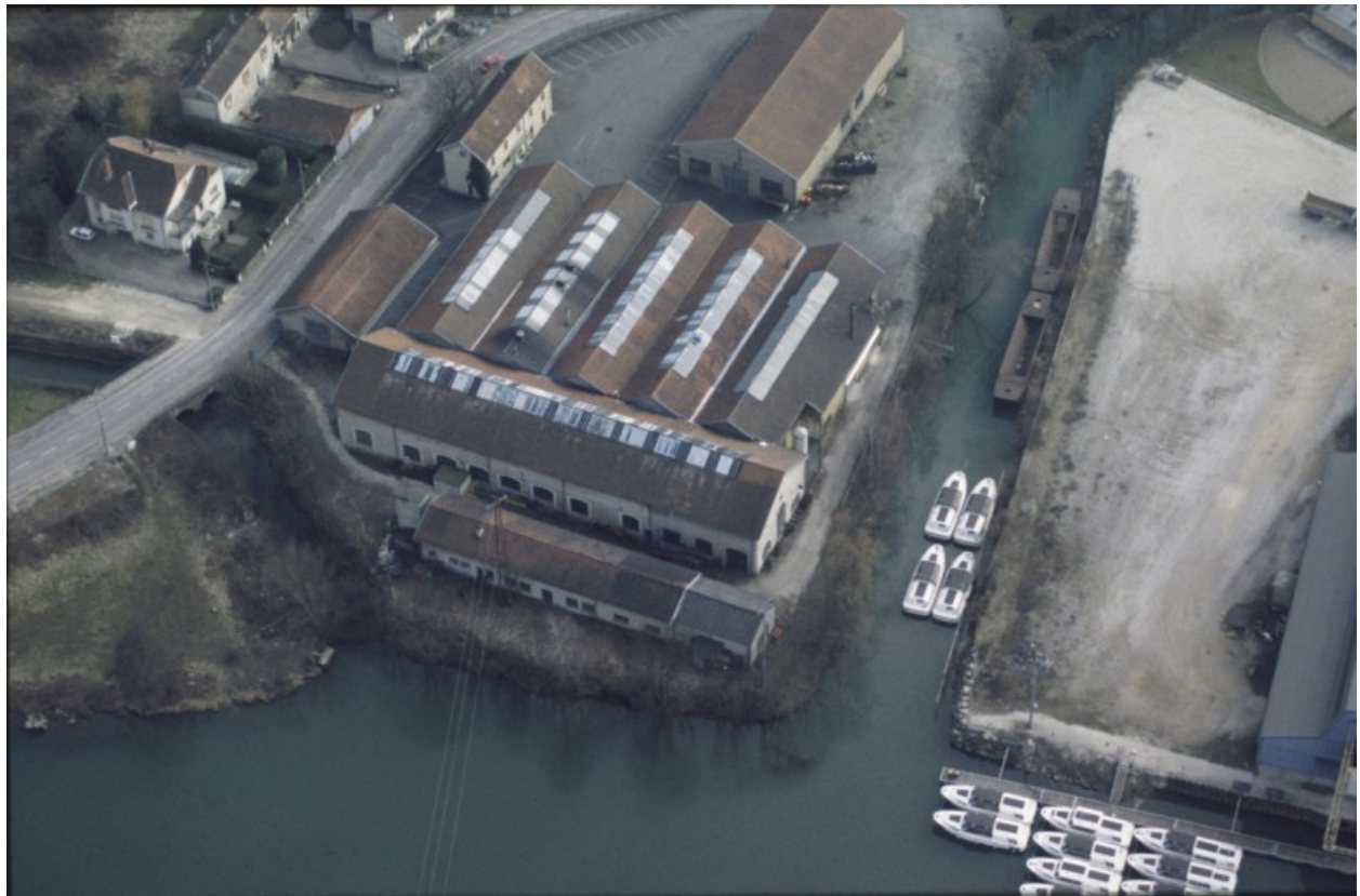
Vue aérienne de l'usine actuelle.
