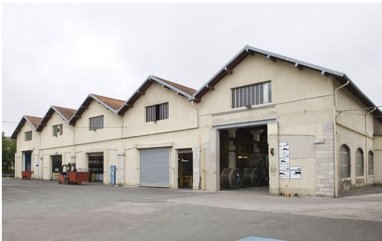
Atelier de fabrication (ancien atelier des locomotives).
