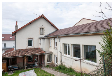
Logement (façade postérieure) et atelier. Phot. Jérôme Mongreville IVR43_20152502146NUC4A
