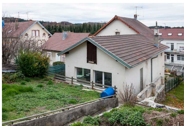
Atelier, depuis l'est. Phot. Jérôme Mongreville IVR43_20152502145NUC4A
