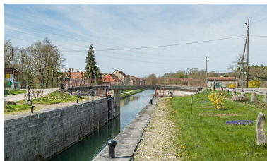
Vue depuis le sas. Phot. Pierre-Marie Barbe-Richaud IVR26_20138900041NUC4AQ
