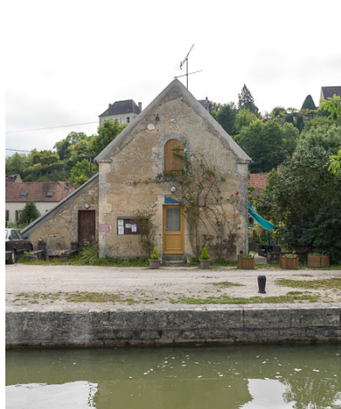
Mur pignon de la maison éclésièr Phot. Pierre-Marie Barbe-Richaud IVR26_20178900077NUC2A
