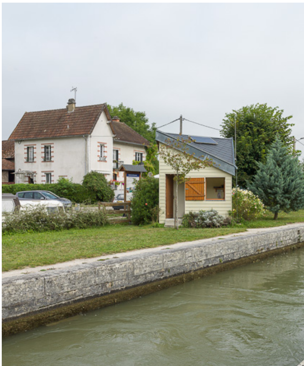
Maison du garde barrière.
