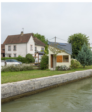
Maison du garde barrière. Phot. Pierre-Marie Barbe-Richaud IVR26_20178900076NUC2A
