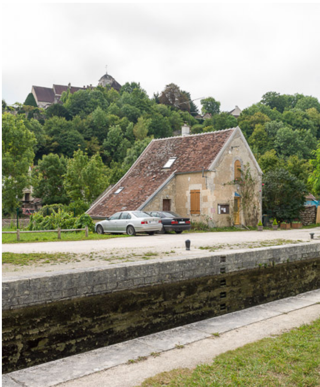
Vue de la maison éclusière.
