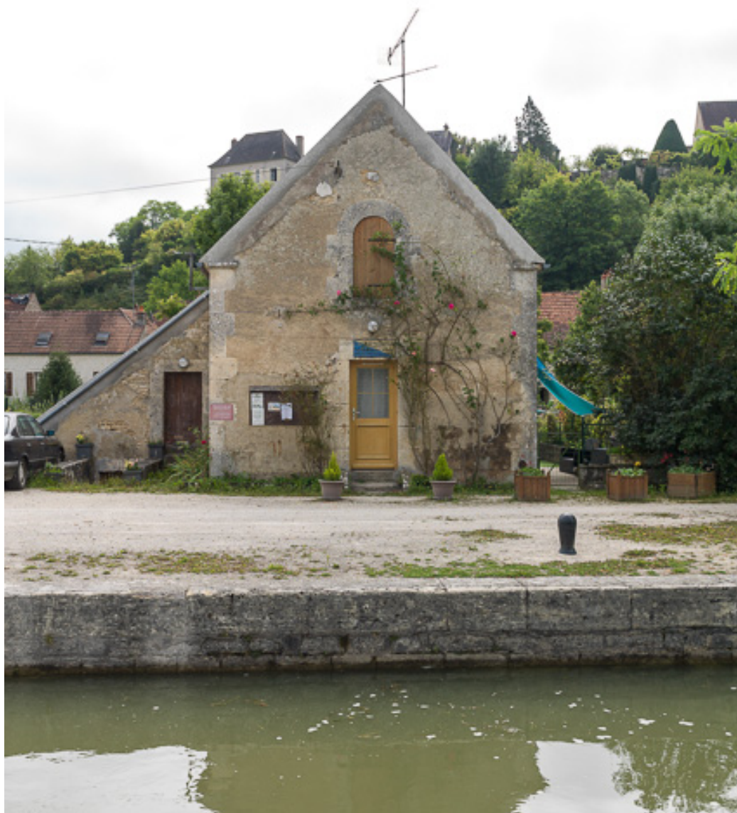
Mur pignon de la maison éclusière
