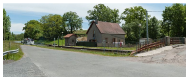
Vue d'ensemble. Phot. Pierre-Marie Barbe-Richaud IVR26_20137100406NUC2AQ
