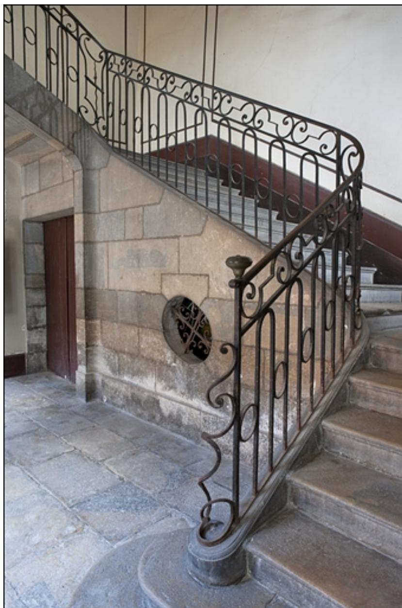
Détail du départ de l'escalier principal.
