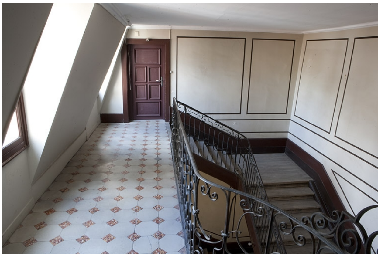
Détail du dernier palier de l'escalier principal.
