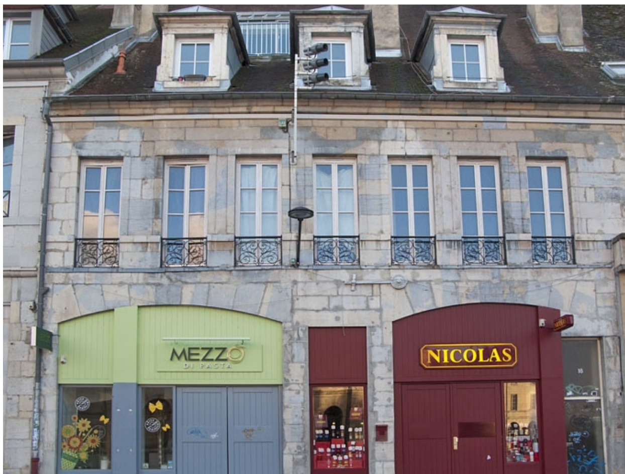
Vue d'ensemble rapprochée de la façade antérieure.
