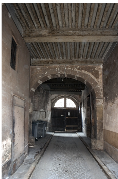
Vue d'ensemble du passage cocher, de face. Phot. Yves Sancey IVR43_20102500302NUC2A
