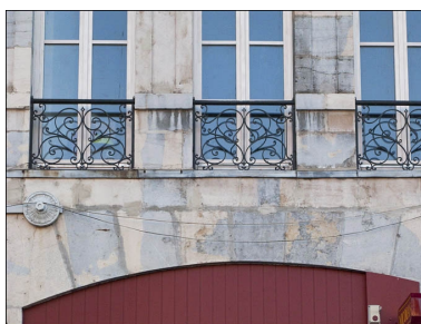
Façade antérieure : détail des garde- corps des fenêtres du premier étage. Phot. Yves Sancey IVR43_20102500290NUC2A
