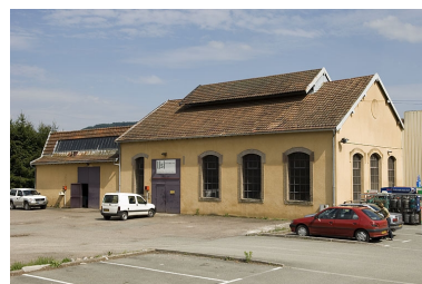
Salle des machines (?). Phot. Jérôme Mongreville IVR43_20067000352NUCA
