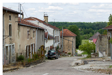
Alignement rue de la fontaine. Phot. Sonia Dourlot IVR43_20157001282NUC2A
