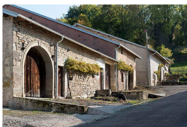
Alignement rue de la fontaine. Phot. Sonia Dourlot IVR43_20157001280NUC4A
