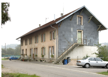
Logements d'ouvriers, bâtiment A, rue du Coney. Phot. Jérôme Mongreville IVR43_20077000564NUCA
