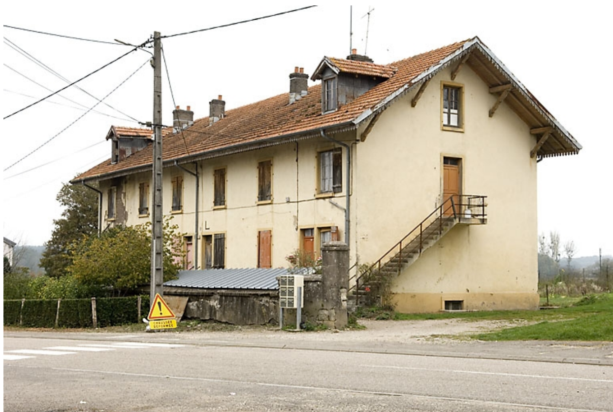
Logements d'ouvriers, bâtiment L, 4 rue du Coney.
