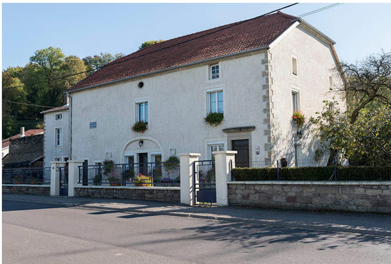
Maison 35, grande rue, vue de trois-quart nord-ouest.
