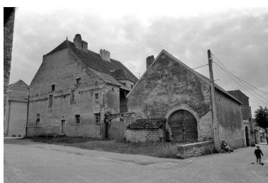
Façade latérale droite et bâtiment agricole. Phot. Bernard Lardière IVR43_19817000672Z
