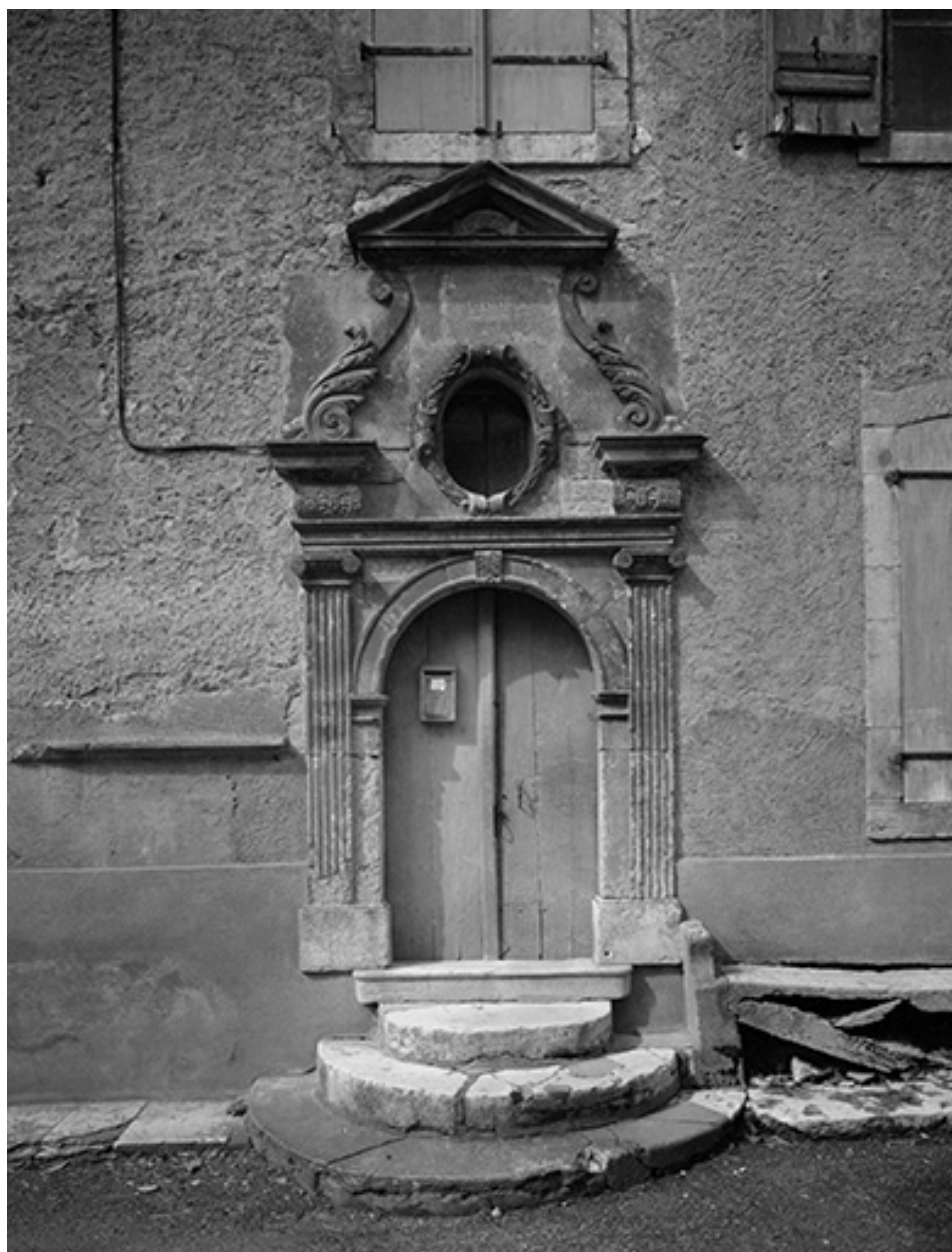
Détail du portail d'entrée.
