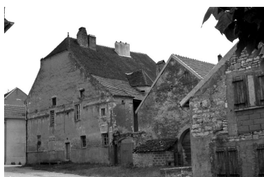
Façade latérale droite. Phot. Bernard Lardière IVR43_19817000673Z
