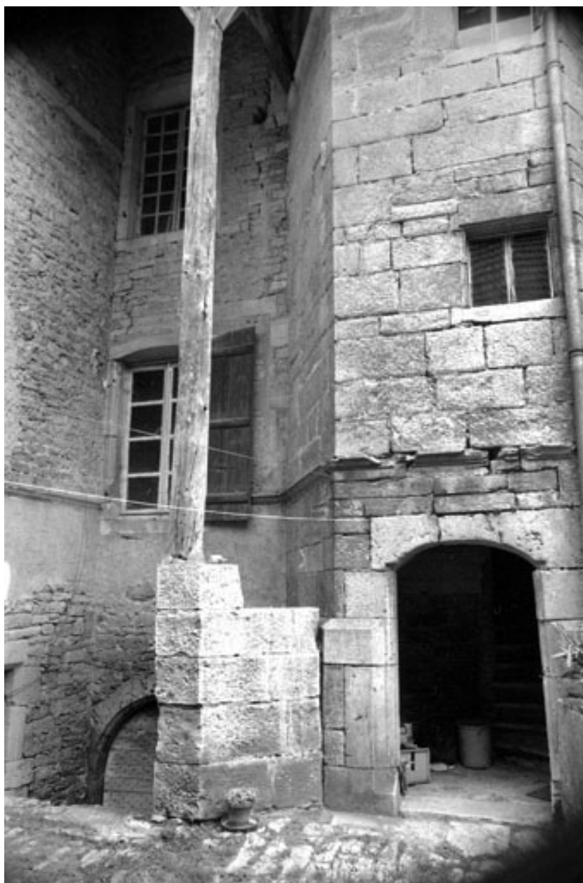
Entrée de cave et escalier en vis.
