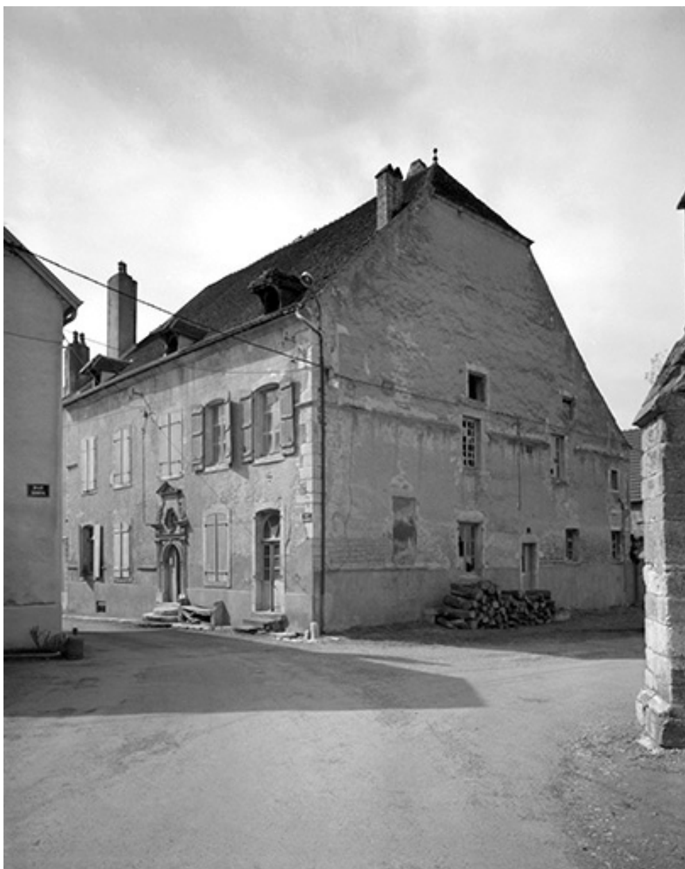
Vue d'ensemble de trois quarts droit.
