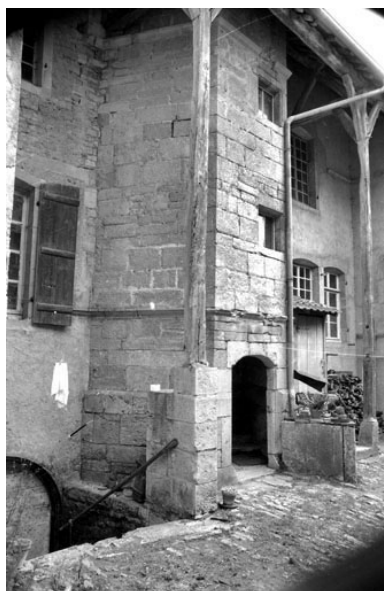
Façade postérieure. Phot. Bernard Lardière IVR43_19817000676Z
