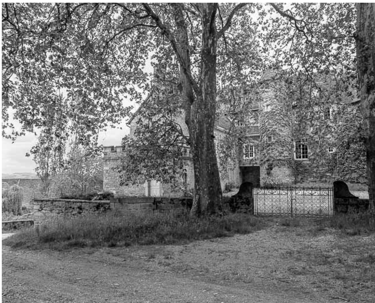
Façade sur cour et portail d'entrée.
