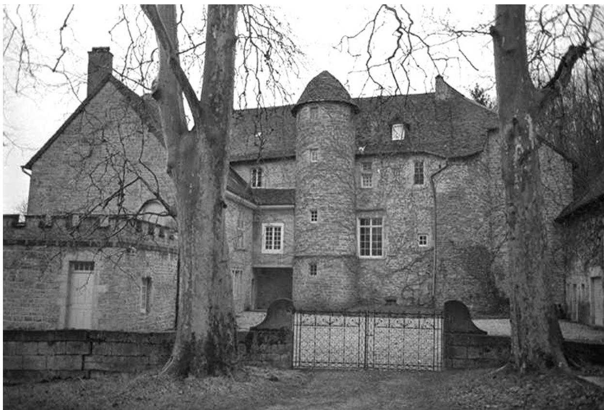
Façade sur cour et portail d'entrée.
