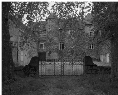
Façade sur cour et portail d'entrée. Phot. Yves Sancey IVR43_19813900082X
