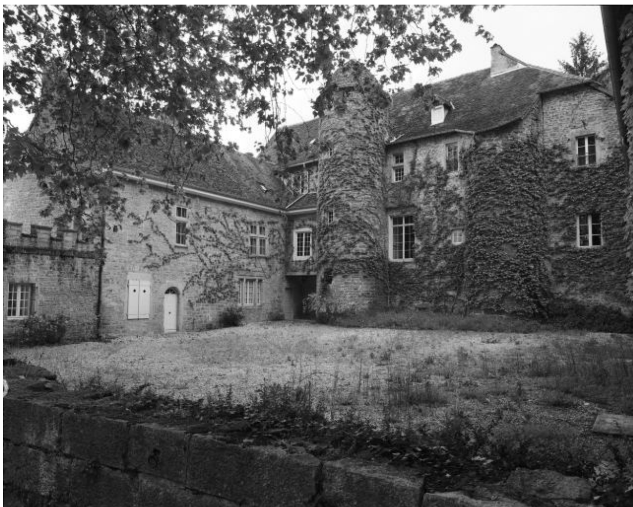
Façade sur cour et aile gauche.
