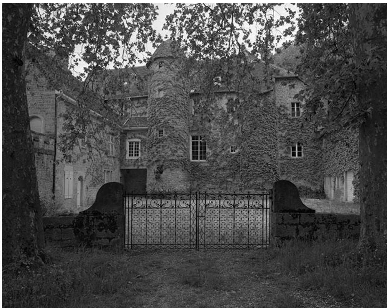
Façade sur cour et portail d'entrée.
