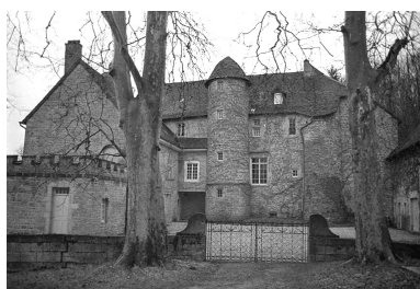
Façade sur cour et portail d'entrée. Phot. Guy Forestier IVR43_19743900369Z
