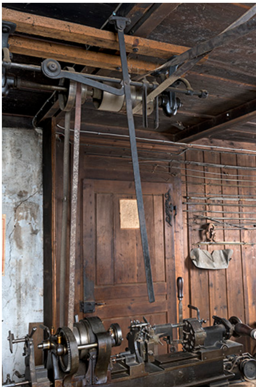
Système de transmission au plafond.
