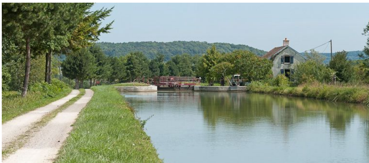
Vue du site d'écluse en amont.
