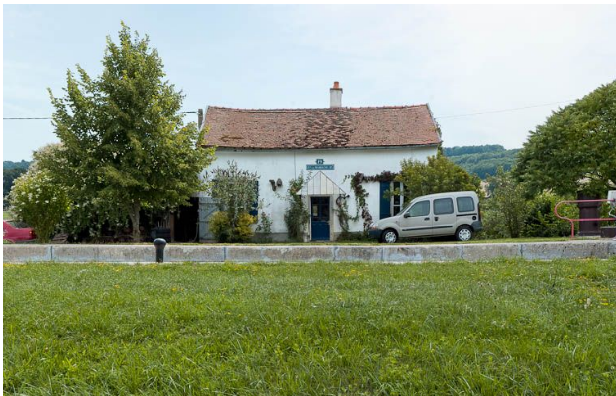
Vue de face de la maison éclusière.
