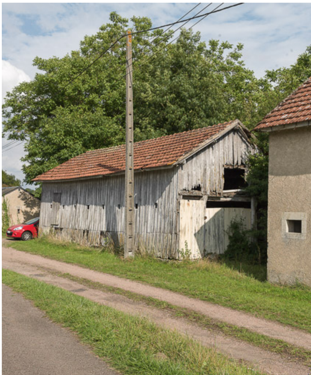
Vue de l'extension de la maison éclusière.
