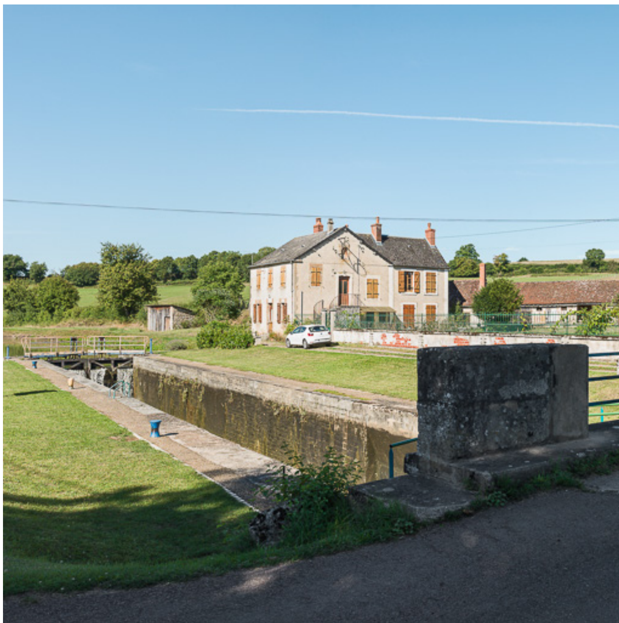
Vue du site d'écluse.
