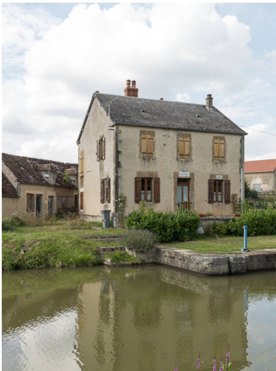
Vue de la maison éclusière.
