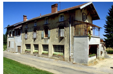
Façade sur rue de trois quarts droite. Phot. Jérôme Mongreville IVR43_19963900451ZA
